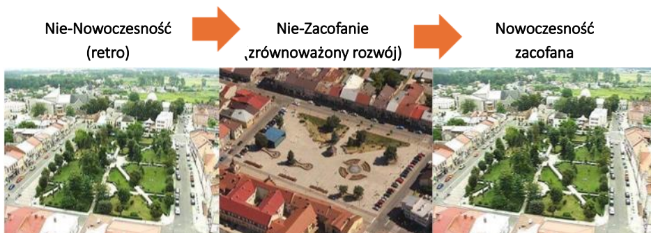
Rys. 6. Rynek w Lubaczowie przed modernizacją (po lewej) i po modernizacji (w środku). Po prawej wizualizacja, jak w odpowiedzi na zakwalifikowanie go jako przejawu „betonozy” mógłby wyglądać po ewentualnej modernizacji
