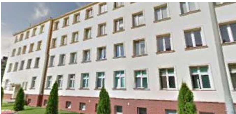
Ryc. 3. Wojewódzka Stacja Pogotowia Ratunkowego – siedziba firmy (stan obecny)
