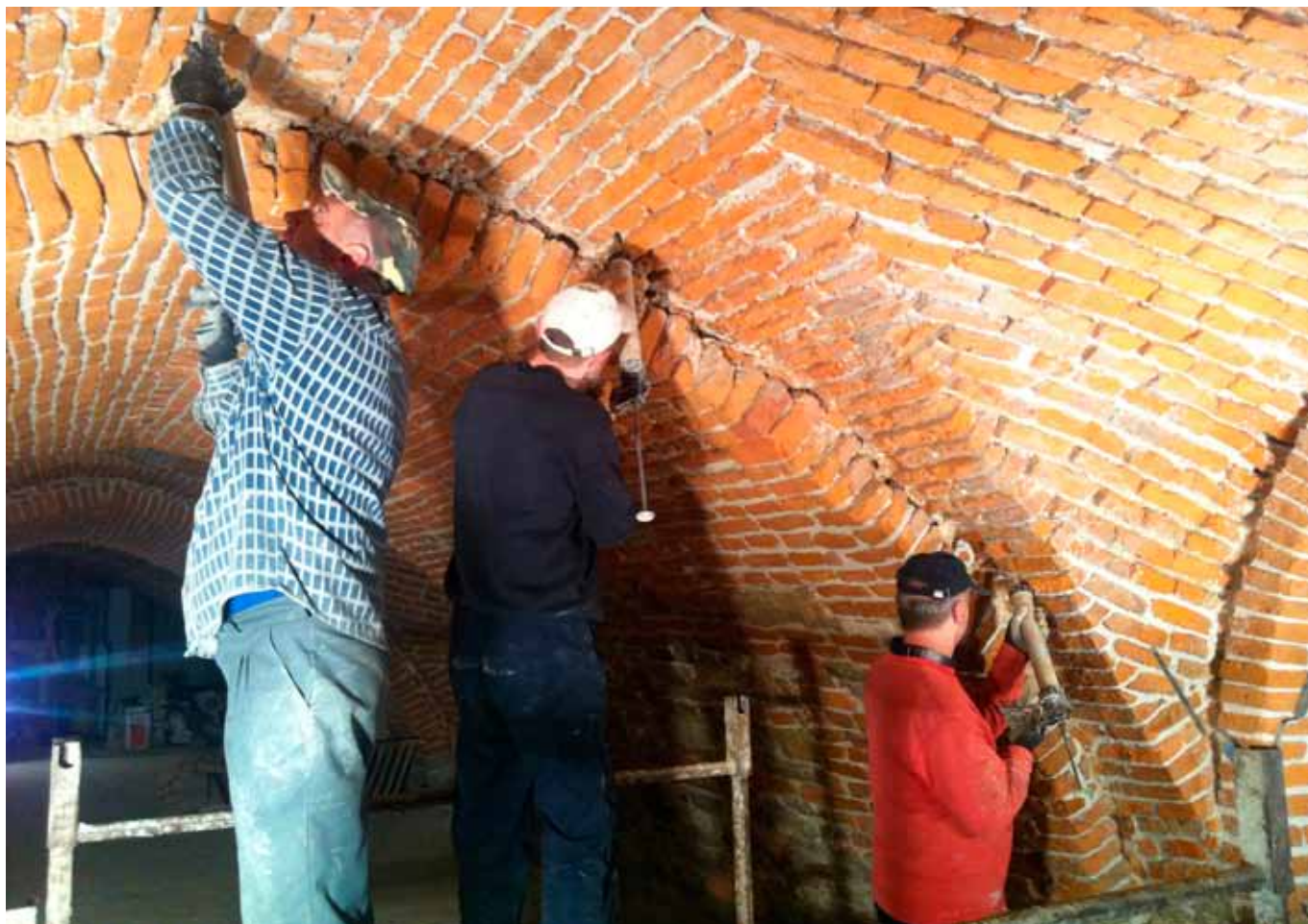
Fot. 87. Uzupelnianie spoin w krypcie glownej
