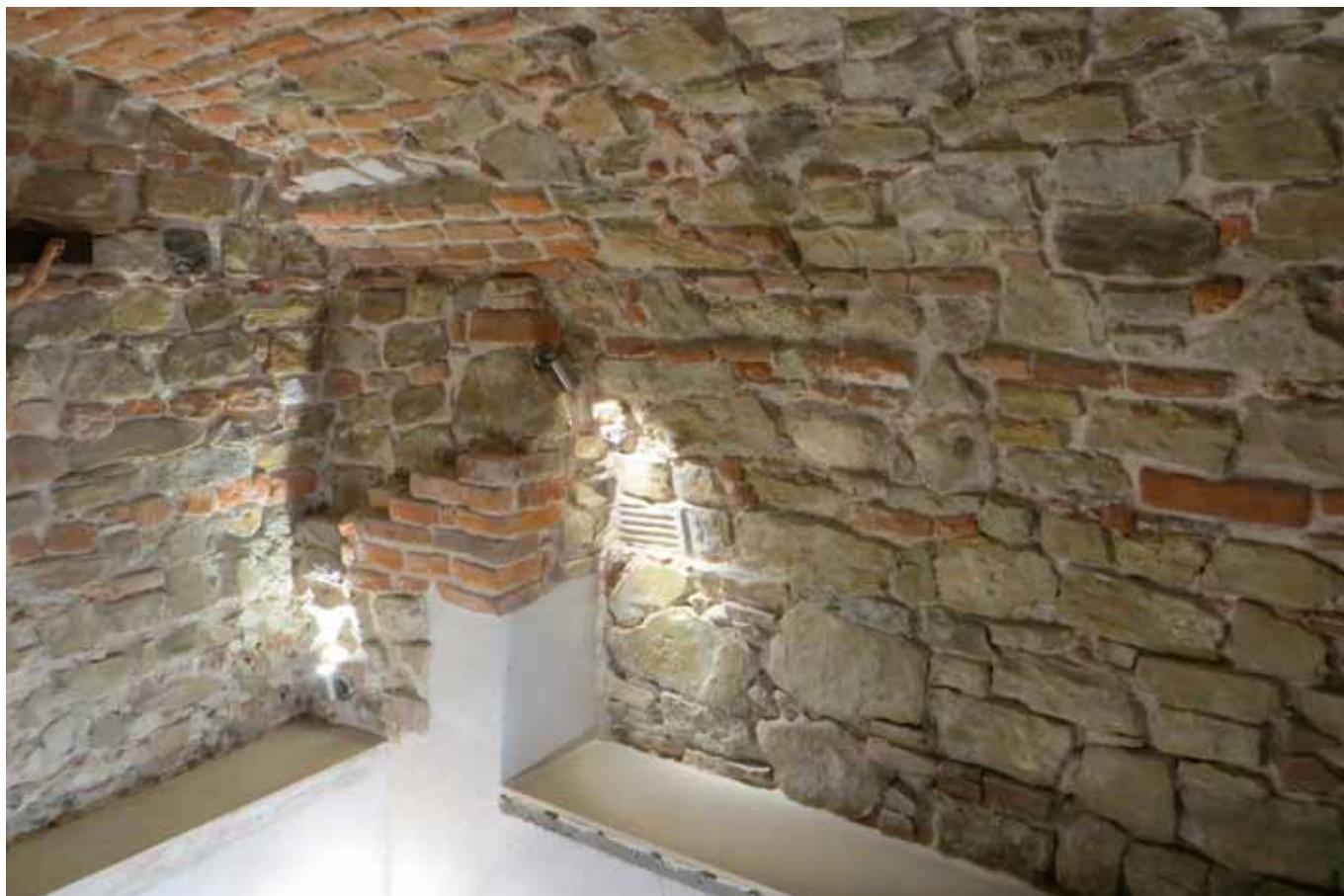
Fot. 56. Krypta północna, tzw. krypta biskupów sufraganów, po rewitalizacji kamiennego sklepienia. Centralnie ukazany jest poprzez podświetlenie element architektoniczny z tryglifem, najprawdopodobniej z potłuczonych nagrobków lub płyt epitafijnych
