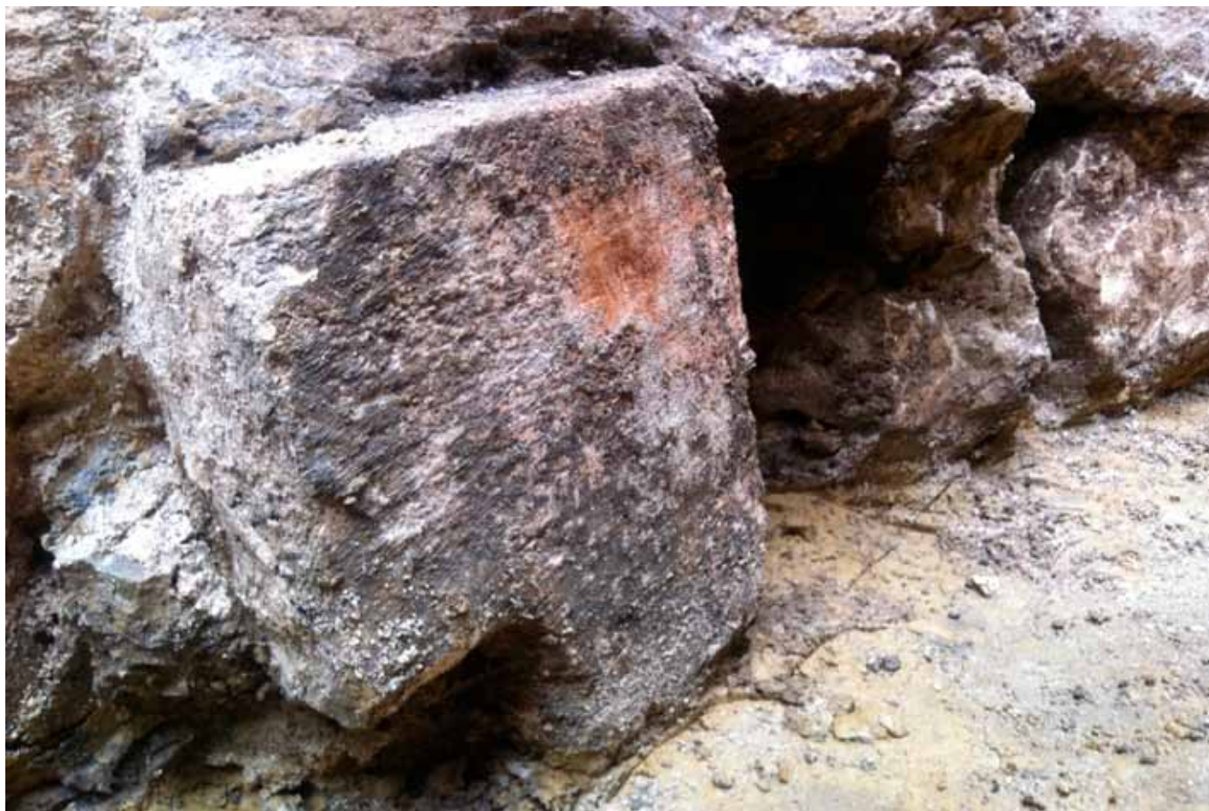
Fot. 103. Fragment muru fundamentowego z ciosami z rotundy lub tzw. cerkwi Wołodara
