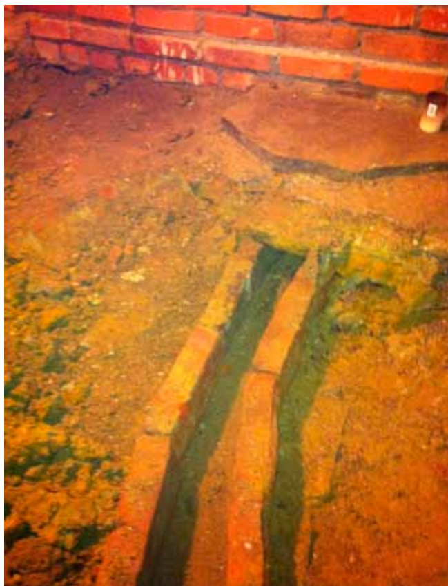
Fot. 59. Ceglany kanał odwadniający w kryptach południowych
