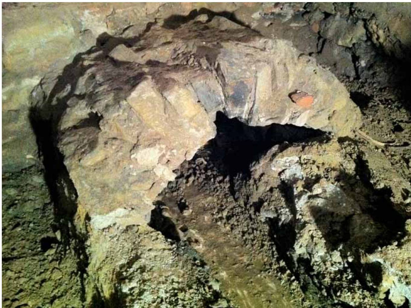
Fot. 44. Fragment zachowanego średniowiecznego kamiennego kanału odwadniającego w krypcie I od strony południowo-zachodniej
