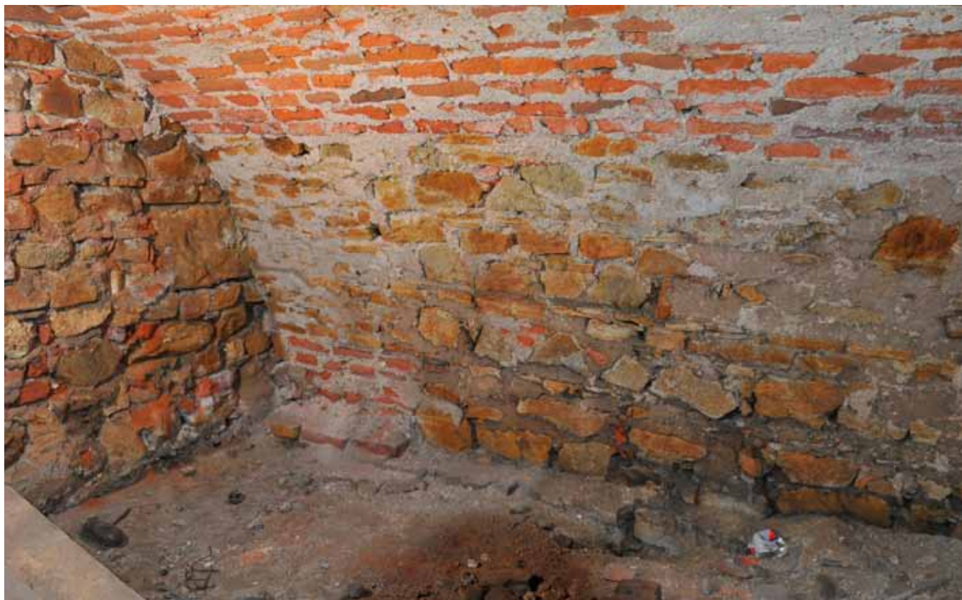
Fot. 58. Widoczne ściany kamiennie-ceglane w północnych kryptach bocznych, powstałych po 1460 roku – stan przed rozpoczęciem prac
