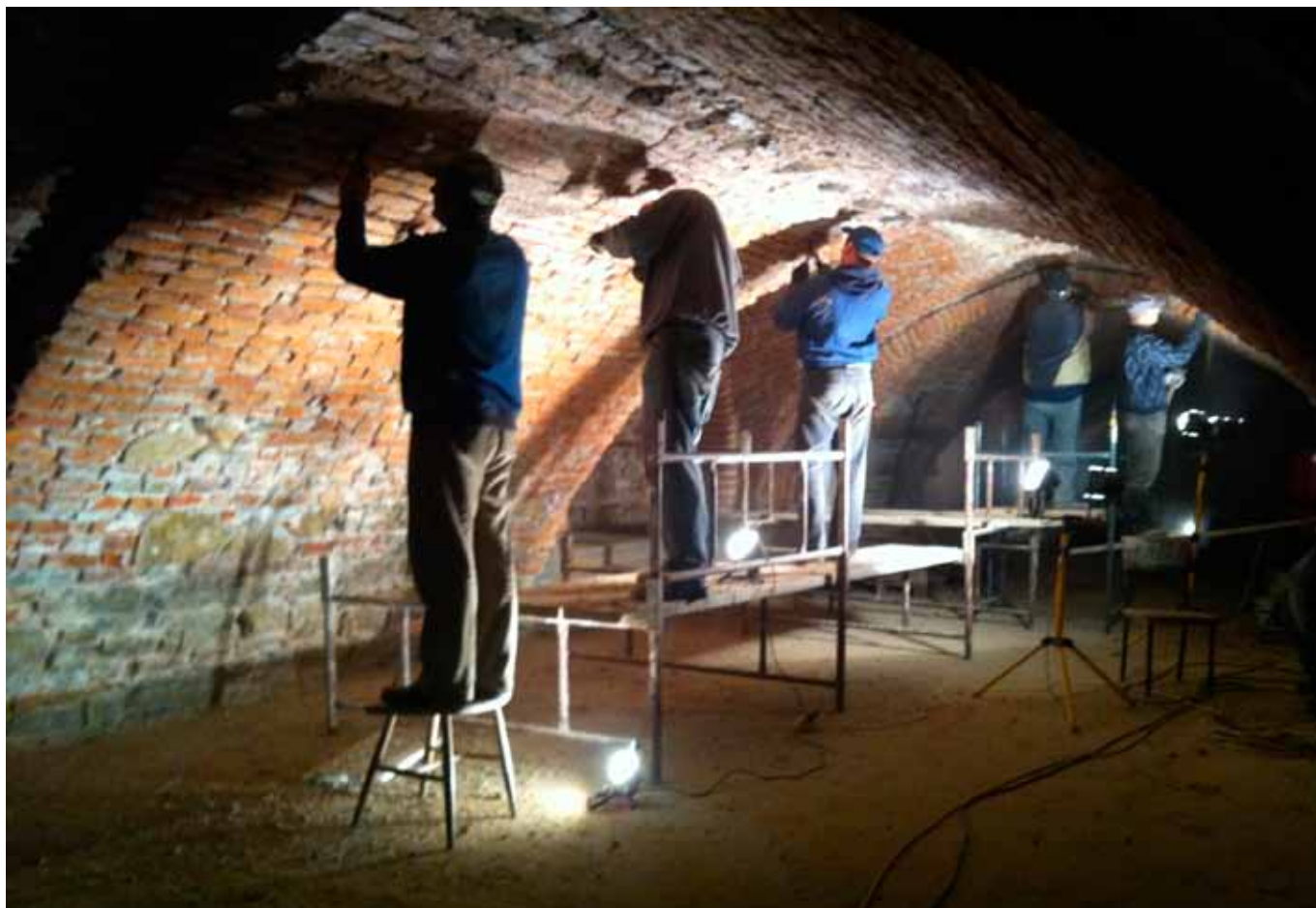
Fot. 85. Czyszczenie spoin w krypcie głównej
