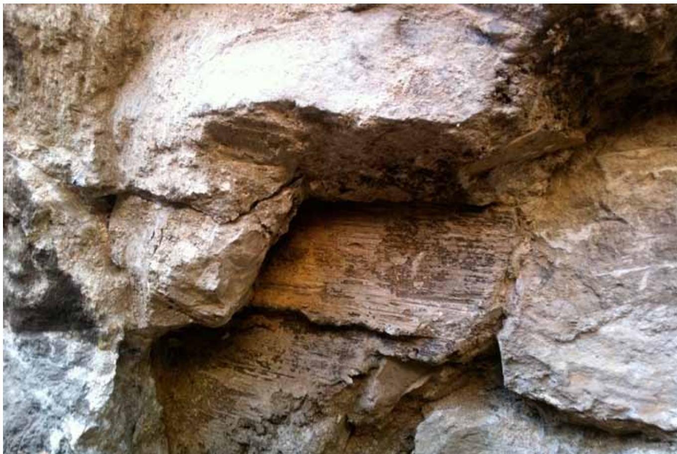
Fot. 102. Fragment muru od strony północnej bazyliki z widocznymi kamieniami z kilku innych budowli, powstałych w różnym czasie w okresie średniowiecza
