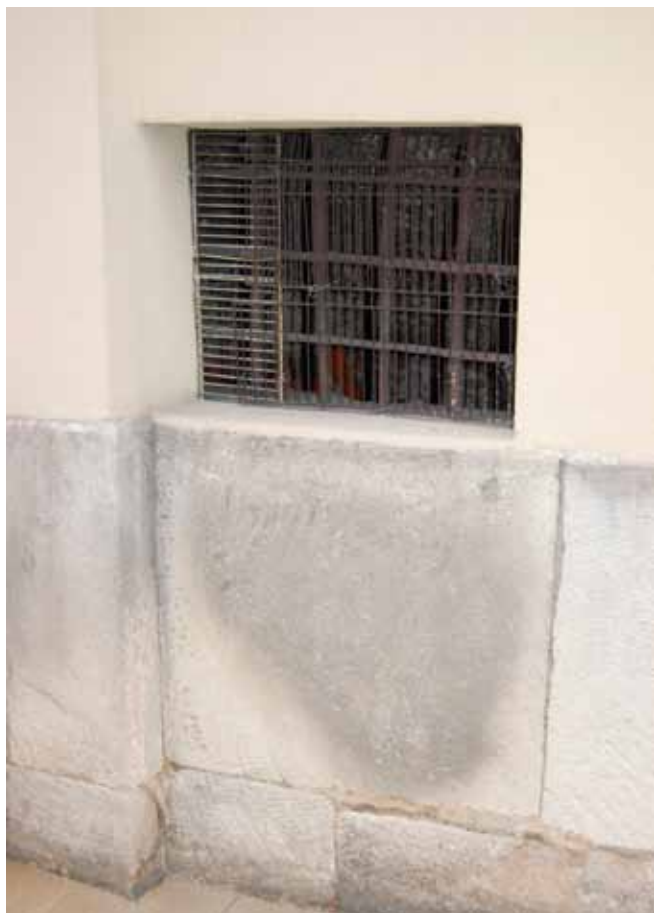
Fot. 34. Okno od strony południowo-zachodniej, którego otwór zmniejszono poprzez zamurowanie w dolnej części
