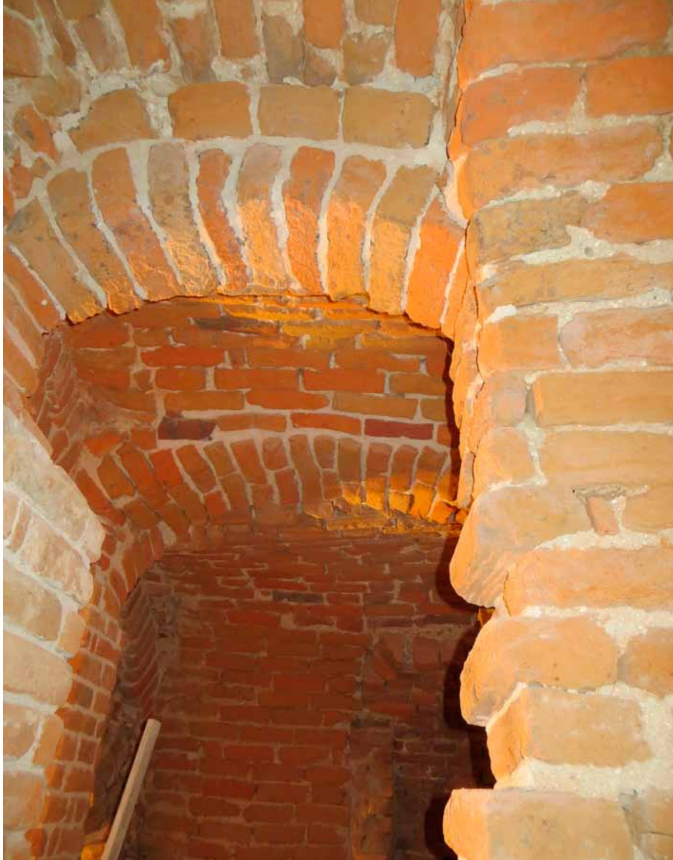
Fot. 26. Fragment sklepienia krypt tzw. gotyckich po renowacji ścian i sklepień
