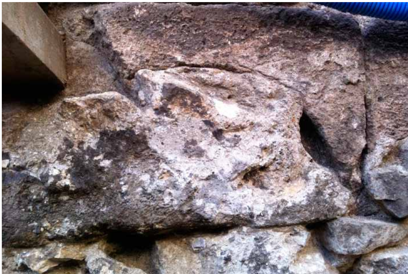
Fot. 98. Fragment detalu romańskiego, wmurowany w fundament i wypełniony zaprawą, odkryty w 2016 roku przez M. Piórkowskiego, wykonawcę robót (firma „Orion”)
