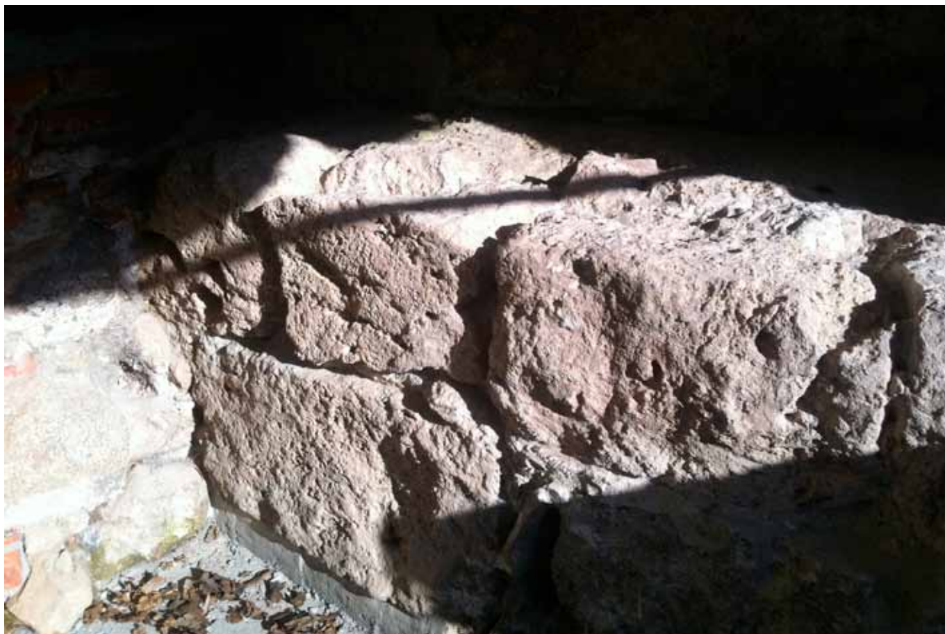
Fot. 94. Ciosy kamienne murów fundamentowych rotundy widoczne na zewnątrz
