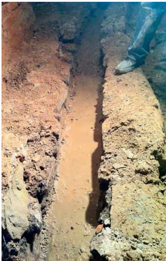
Fot. 45. Kanał odwadniająco wzdłuż ściany zachodniej
