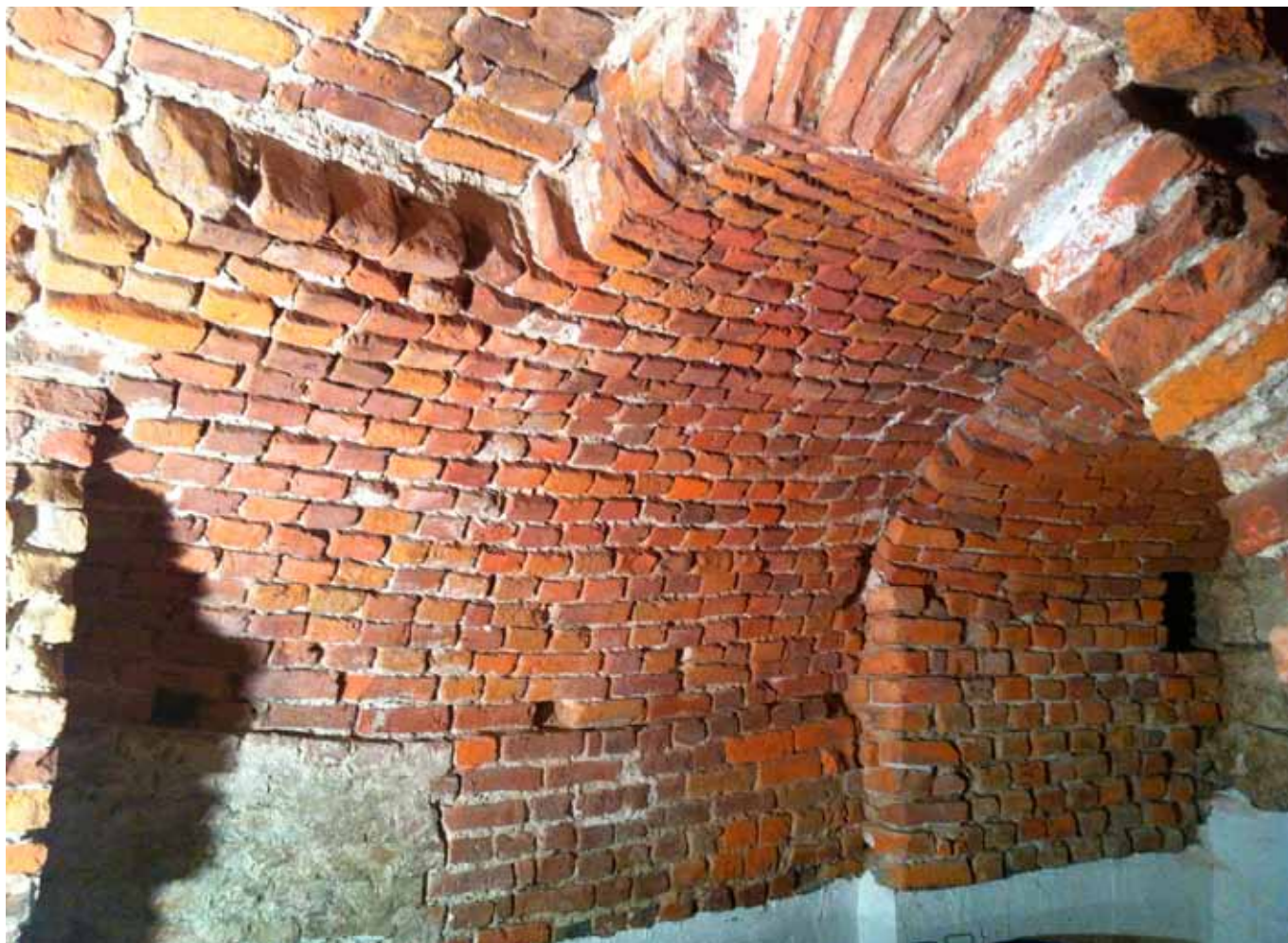
Fot. 23. Krypty tzw. gotyckie przed murem fundamentowym rotundy
