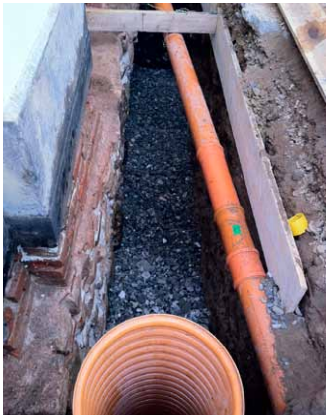
Fot. 52. Zakładanie odwodnienia z drenażem ze żwiru płukanego
