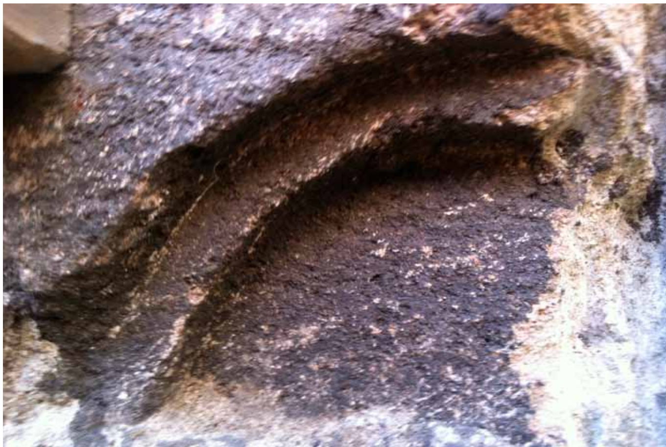
Fot. 100. Fragment wapiennej płyty z detalem romańskim, odnalezioniej w fundamencie podczas wykonywania izolacji pionowej i odwodnienia. Detal odkryty w 2016 roku
