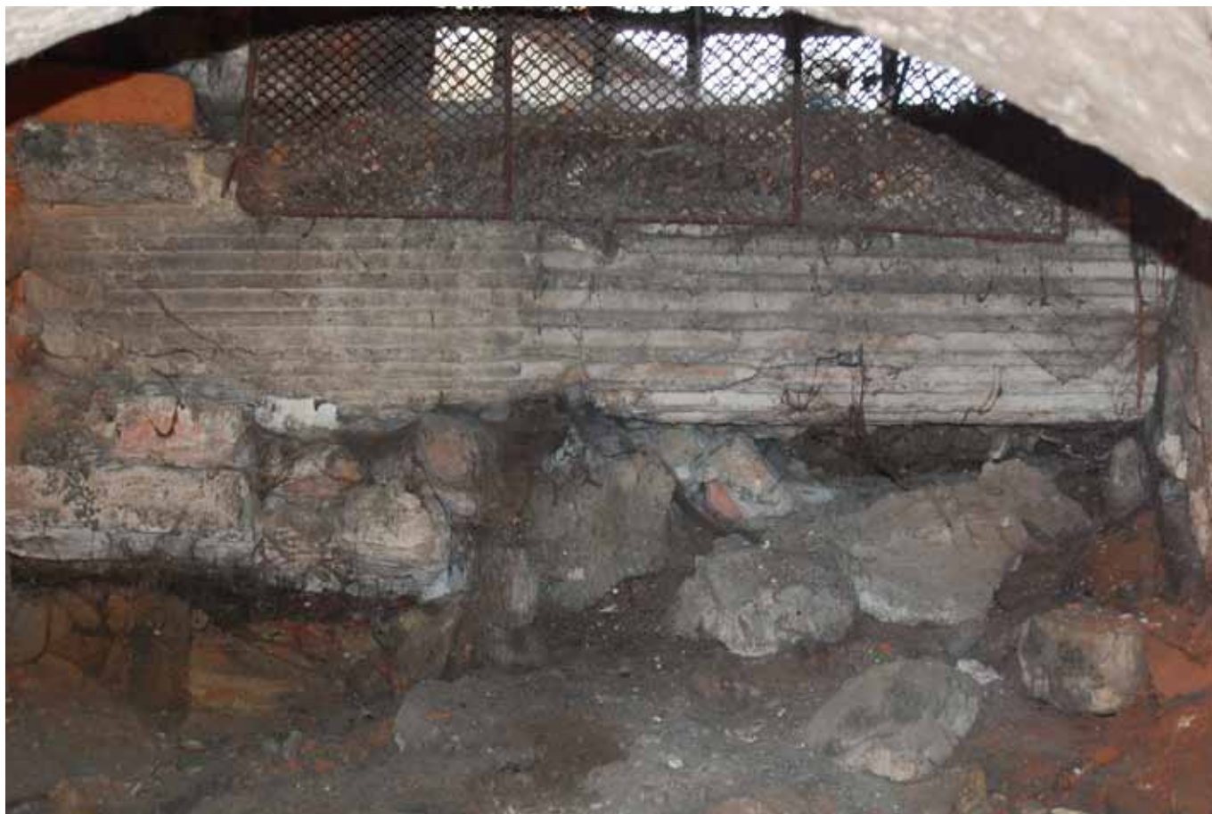
Fot. 33. Podmurowanie okna od wewnątrz krypty bp. A.A. Fredry, do którego użyto kolumny z dawnego wystroju nagrobków, zniszczonych podczas katastrofy w 1733 roku. Stan zachowania – bezpośrednio po odnalezieniu
