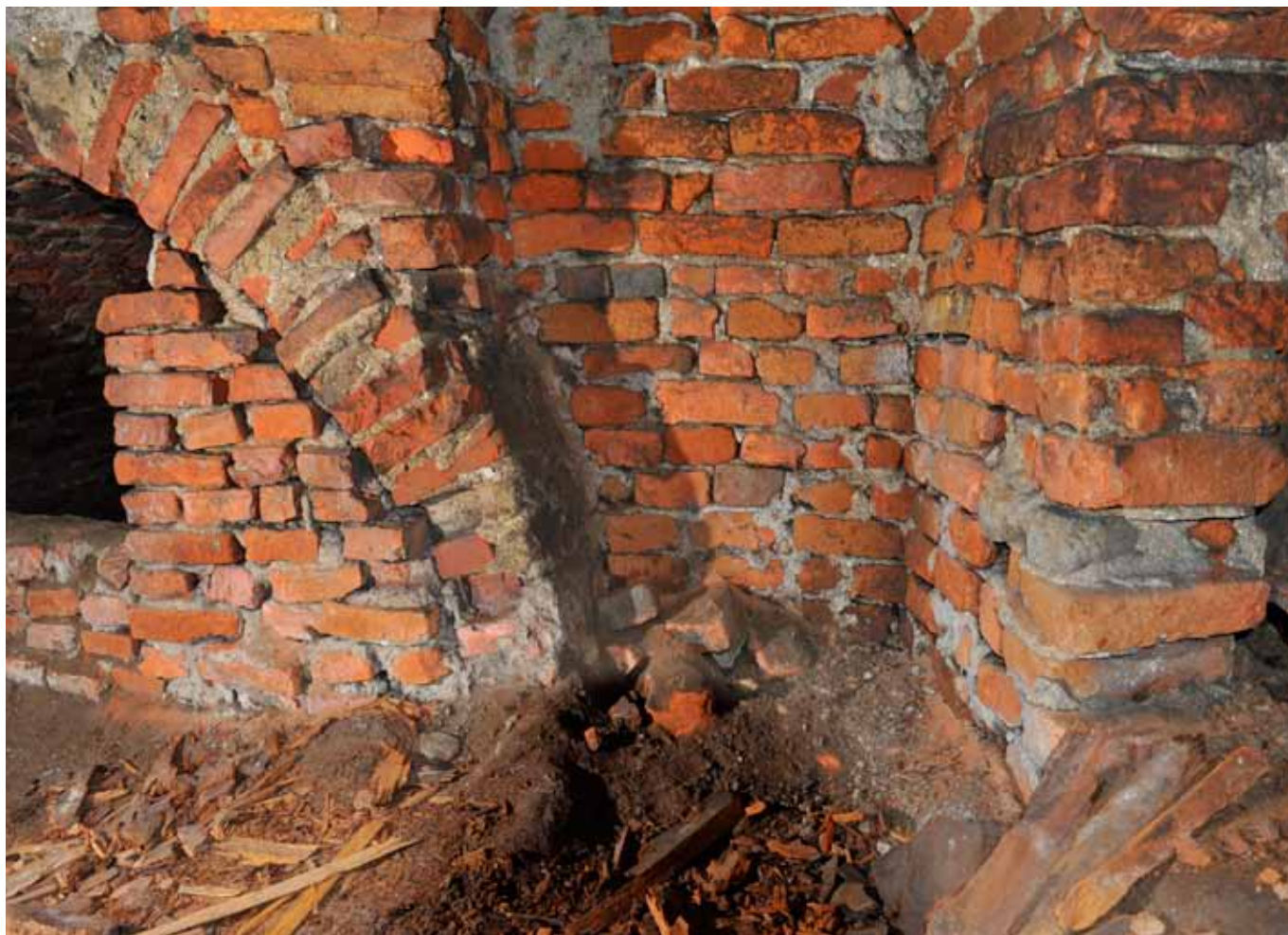
Fot. 25. Fragment sklepienia jednej z krypt tzw. gotyckich przed rozpoczęciem prac
