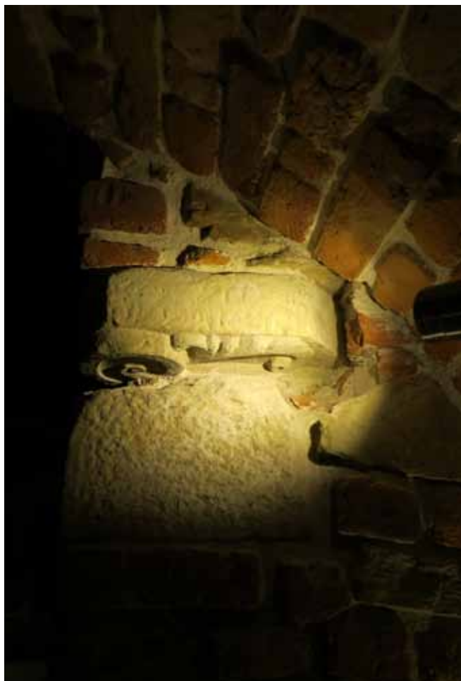
Fot. 5. Krypty południowe po rewitalizacji – detal wtórnie wmurowany w ścianę
