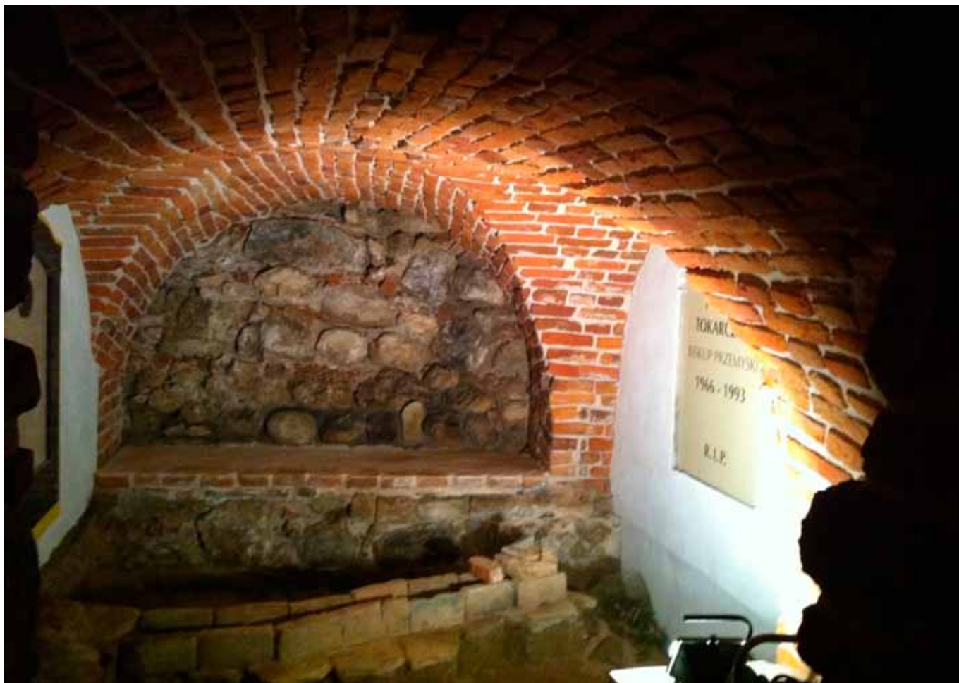
Fot. 49. Na pierwszym planie widoczny ceglany kanał odwadniającający. W tle odsłonięta gotycka ściana południowa w krypcie III.
