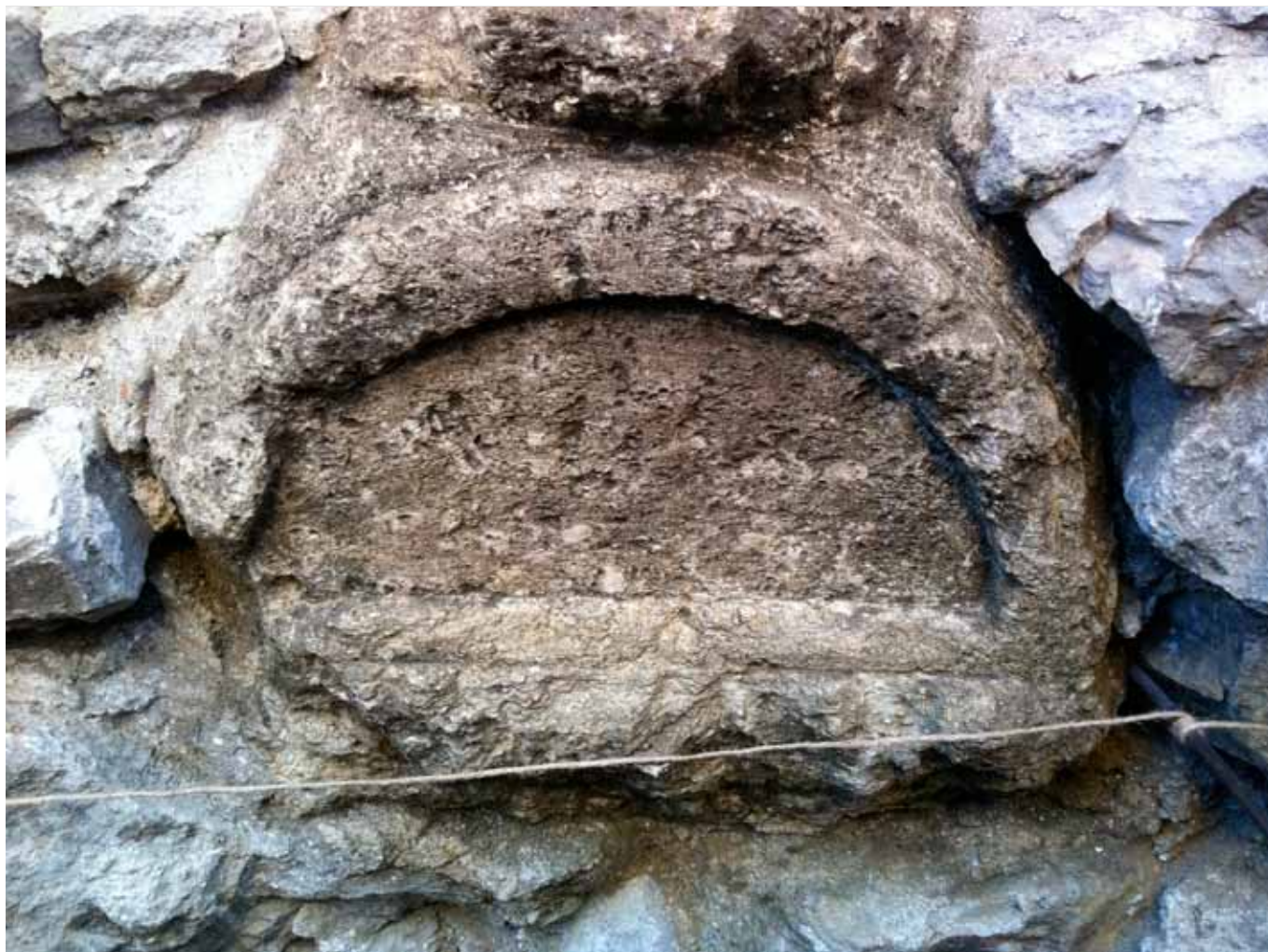
Fot. 10. Romański kapitel kostkowy odnaleziony w fundamencie bazyliki, w który został wtórnie wmurowany po 1460 roku
