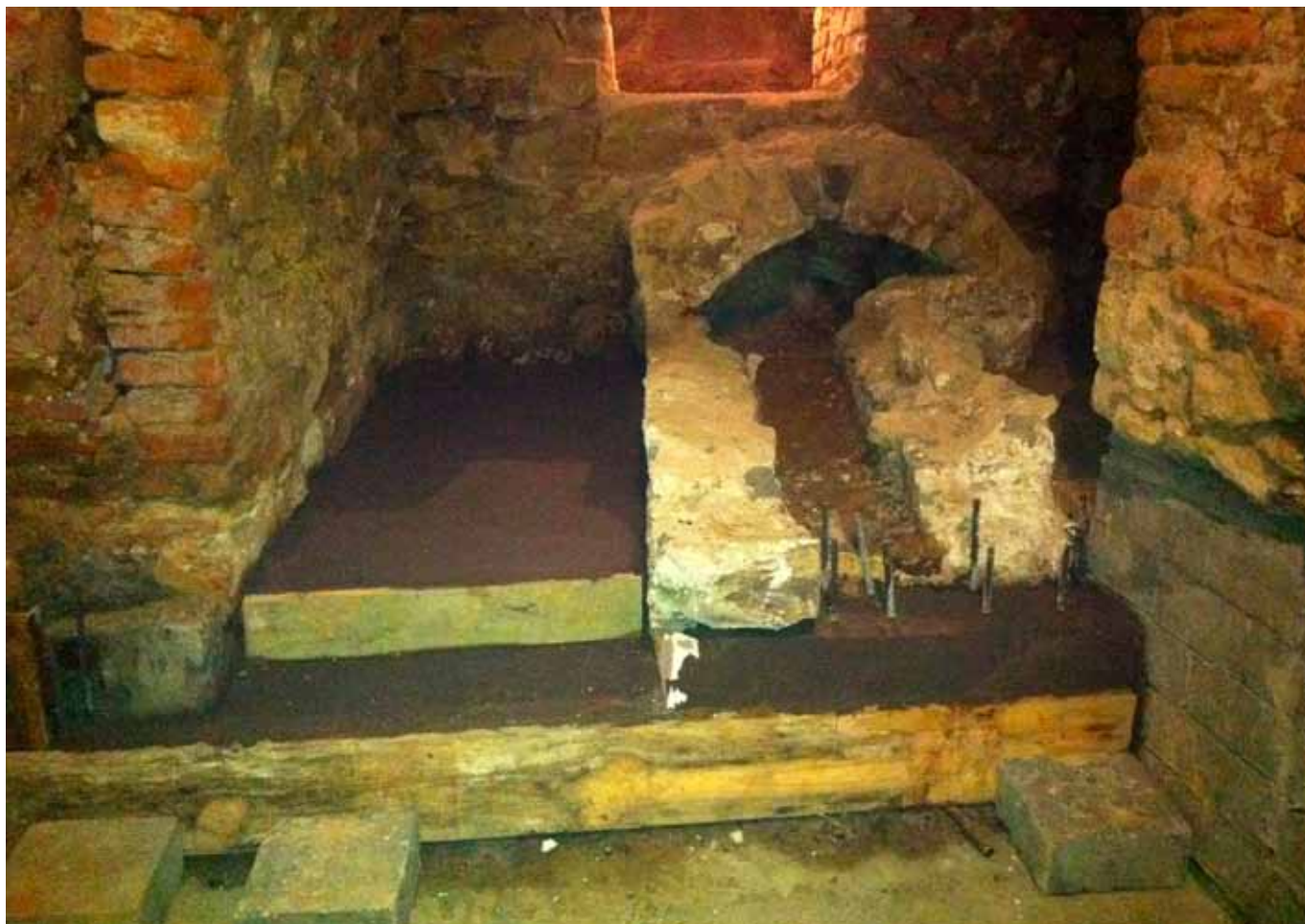
Fot. 48. Zachowanie reliktu kamiennego kanału odwadniającego biegnącego przy ścianie zachodniej, w tle krypta I
