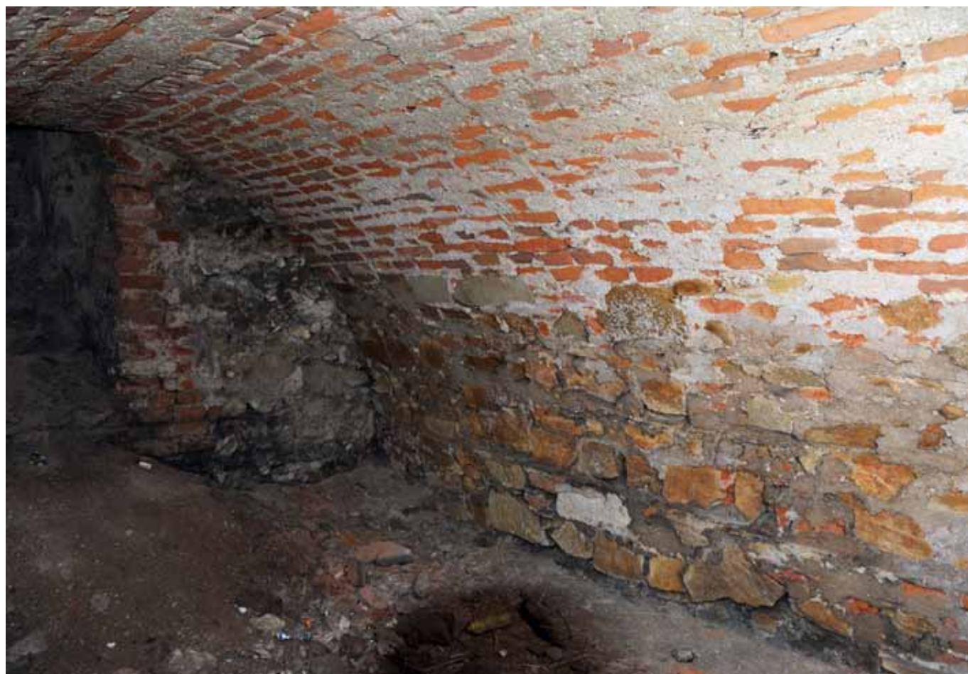
Fot. 15. Ściana krypty bocznej przed rewitalizacją. Widoczny mur kamiennie-ceglany. (W dolnej części kamienny, w części środkowej i na sklepieniu – ceglany)
