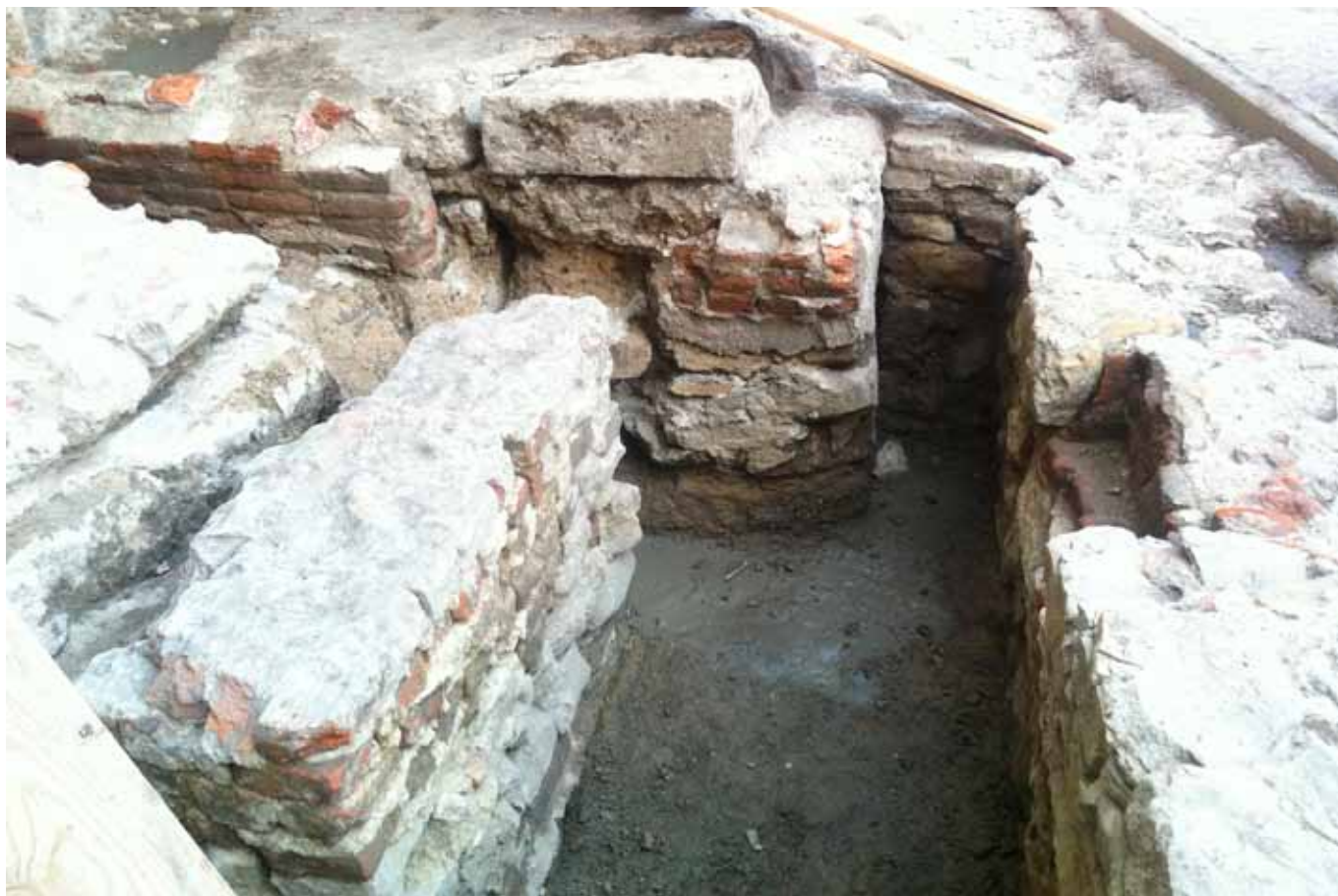
Fot. 93. Po lewej stronie fragment muru fundamentowego rotundy na zewnątrz bazyliki
