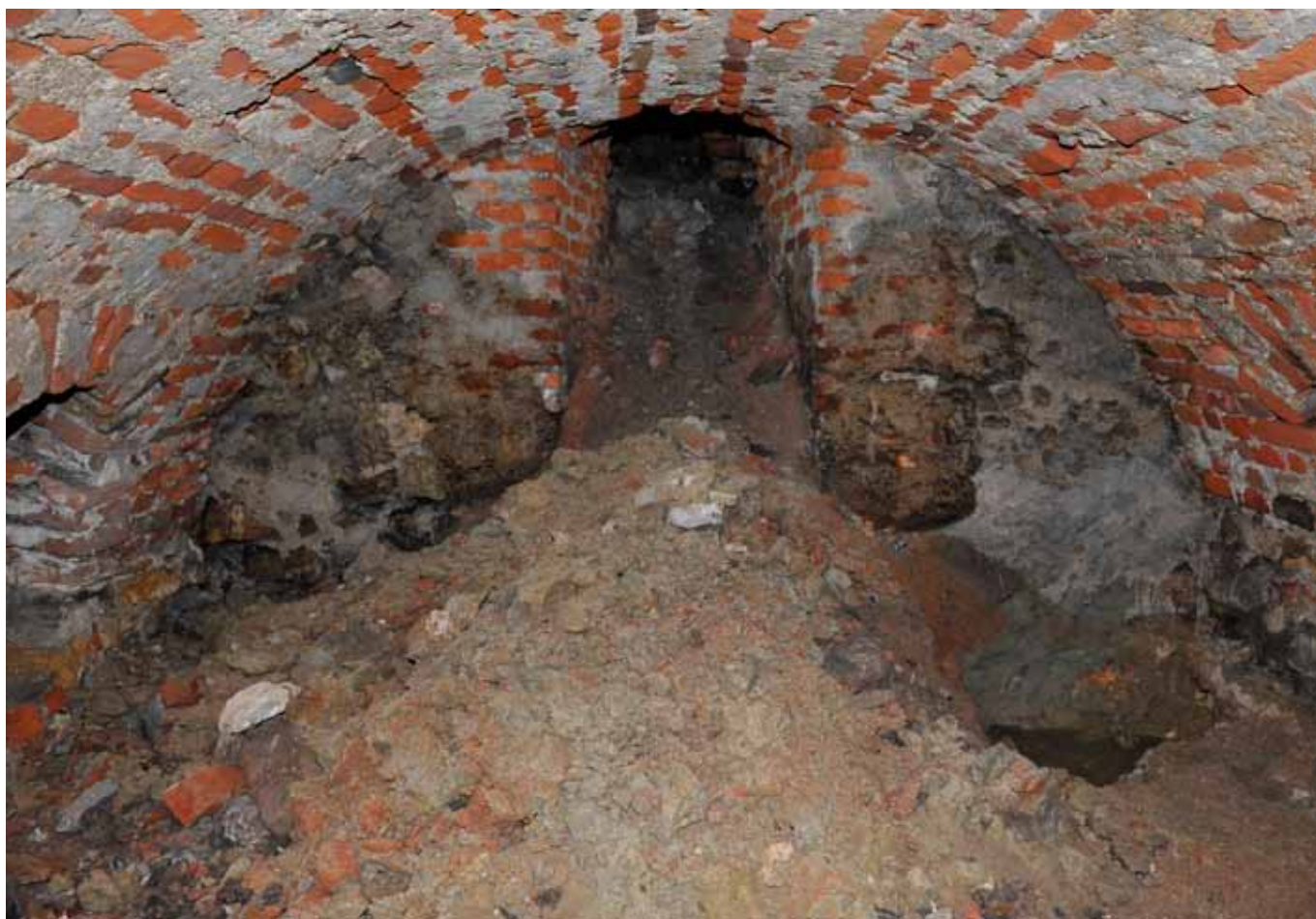
Fot. 21. Wnętrze jednej z krypt północnych przed rozpoczęciem prac
