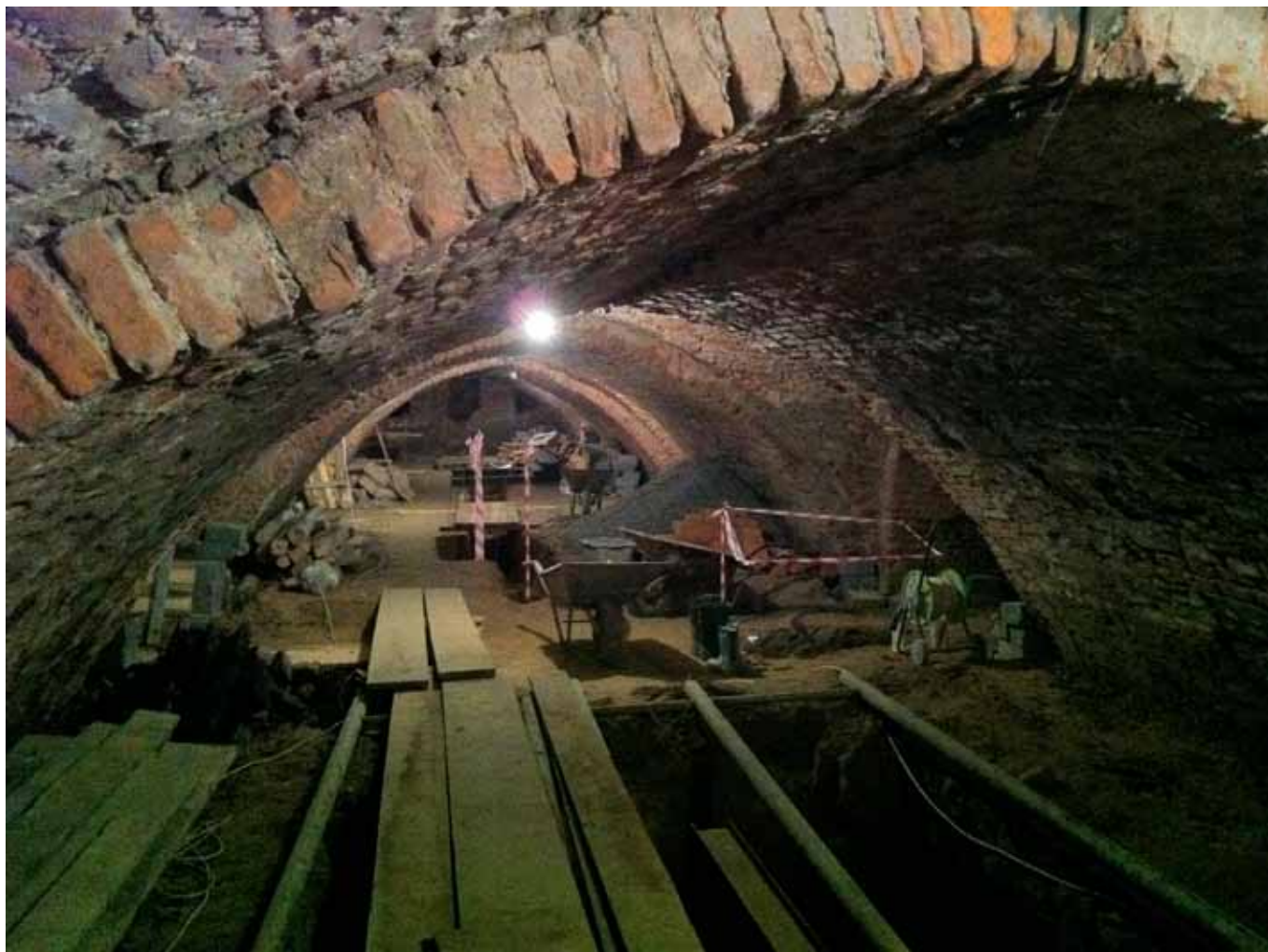
Fot. 41. Krypta główna w trakcie prac; na pierwszym planie krypta bp. A. Gołaszewskiego
