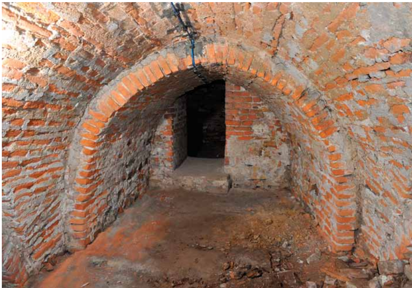
Fot. 20. Płaszcz wzmacniający sklepienie przedsionka jednej z krypt bocznych
