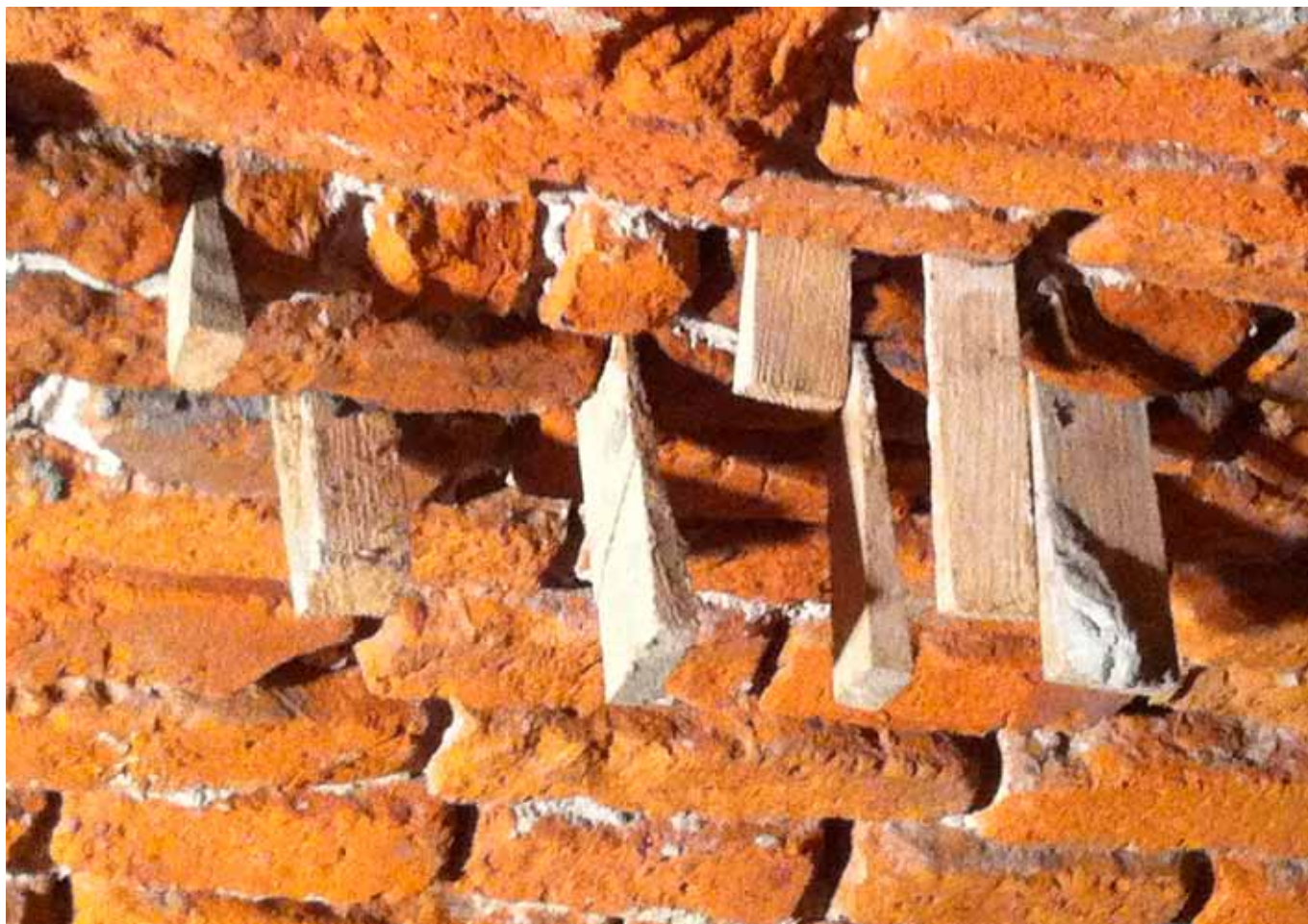
Fot. 88. Uzupełnianie ubytków i wzmacnianie sklepienia
