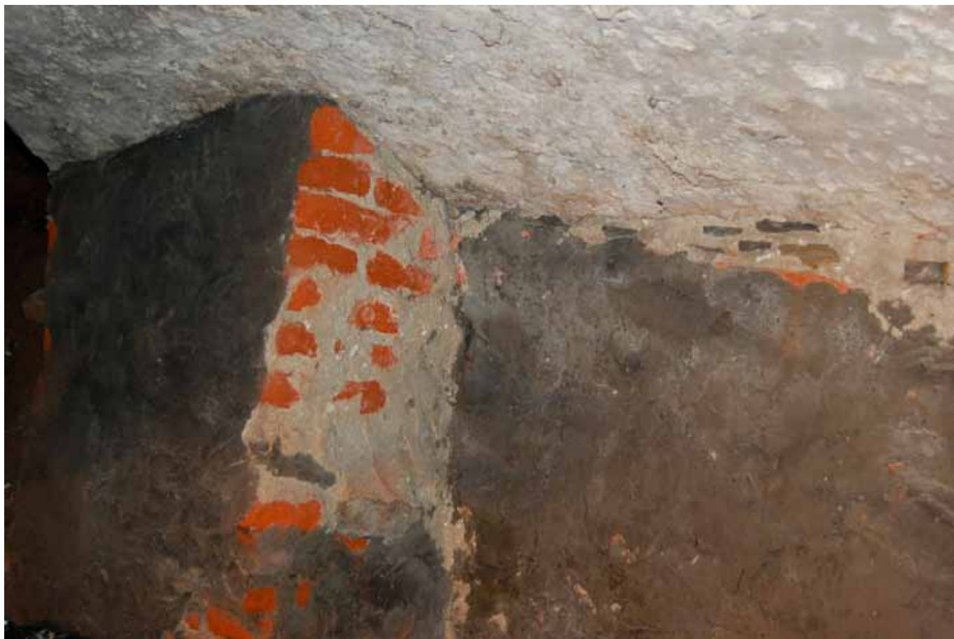
Fot. 31. Wzmocnienie sklepienia krypty Fredrowskiej ceglana, wtórną przyporą w miejscu ustawienia barokowego ołtarza w kaplicy Świętego Krzyża
