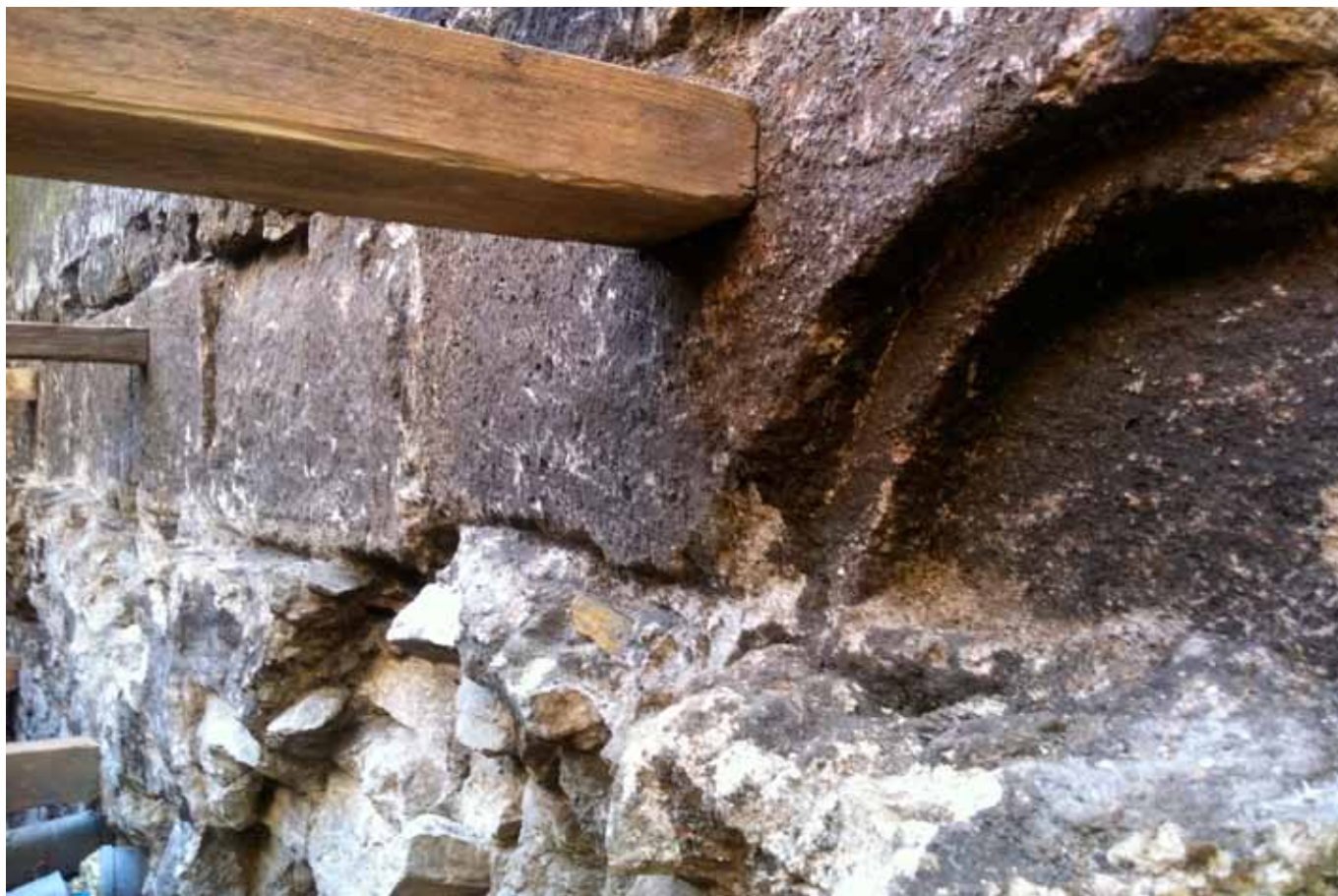
Fot. 101. Fragment odkrytego fundamentu w części północnej bazyliki. W dolnej części fundamentu widoczny jest wcześniejszy mur, najprawdopodobniej z końca XIV wieku. Na nim ułożono fragmenty romańskie, prawdopodobnie z rozbranej rotundy, ułożone dla wyrównania wierzchniej części muru fundamentu, który został po rozbiórce czternastowiecznego kościoła
