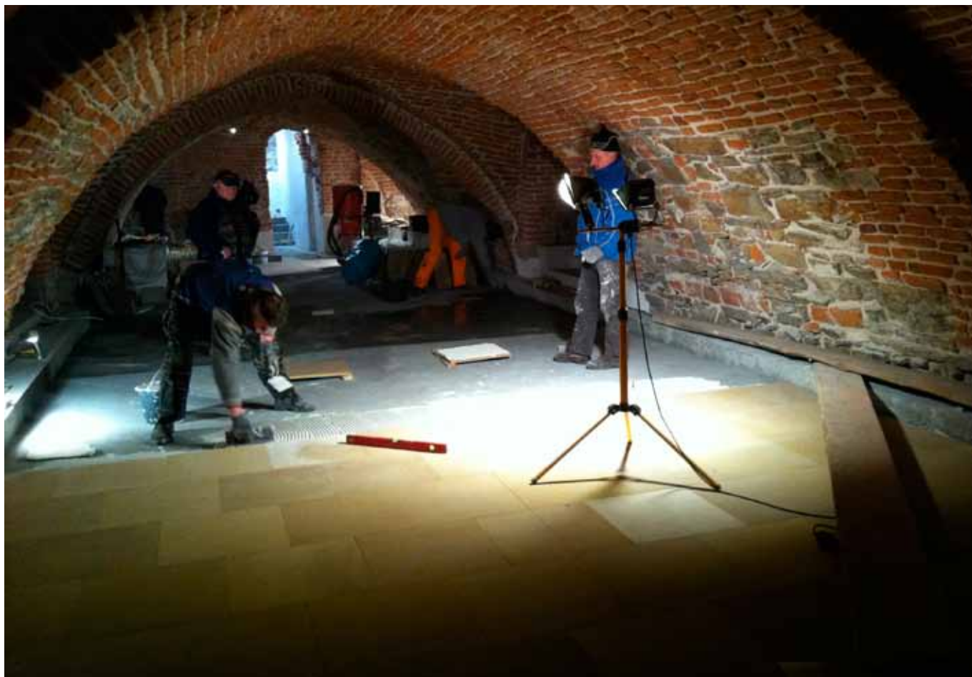
Fot. 89. Układanie posadzki z dolomitu na żelbetowej płycie dennej
