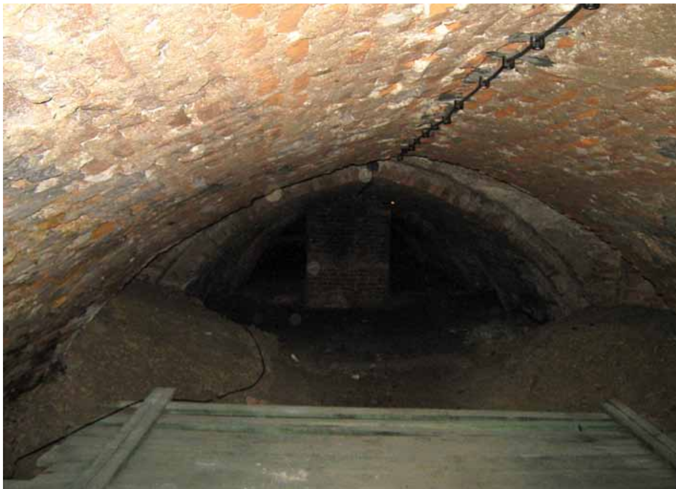
Fot. 81. Widok krypty głównej – stan przed rozpoczęciem prac
