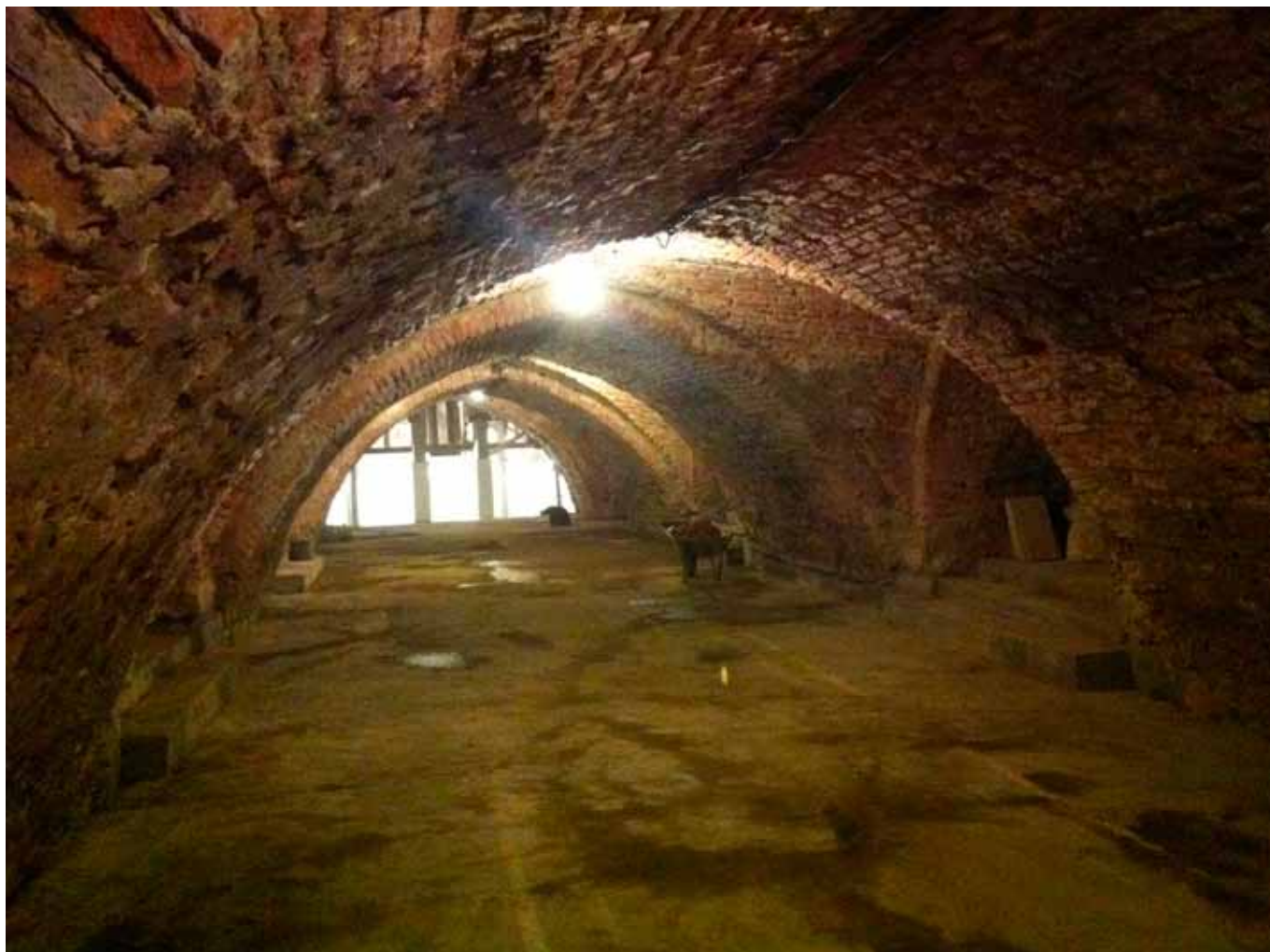
Fot. 84. Płyta denna po zakończeniu betonowania
