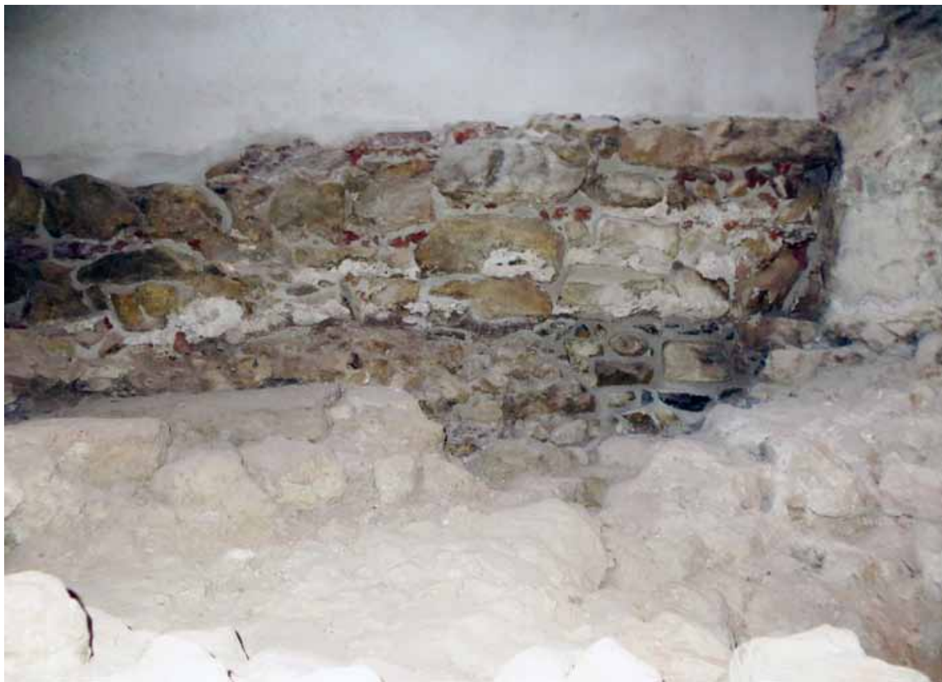
Fot. 80. Późnogotycka kamienna ściana w przedsionku z nielicznymi elementami ceglany jako wypełnienie konstrukcji. Na pierwszym planie widoczne elementy kamiennych relikwów z wcześniejszych inwestycji budowlanych z drugiej połowy XIV wieku i XIV/XV w.
