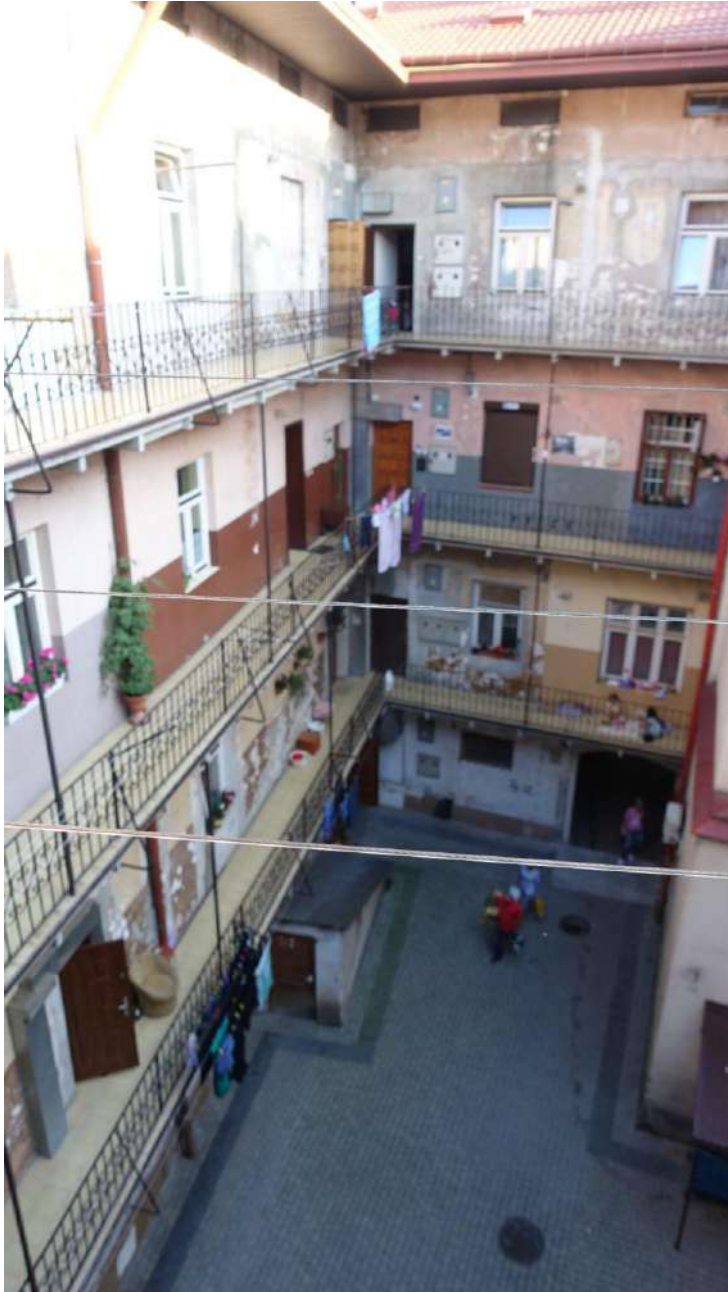
Podwórze kamienicy Rynek 26, stan z 2020, fot. Jadwiga Sawicka
