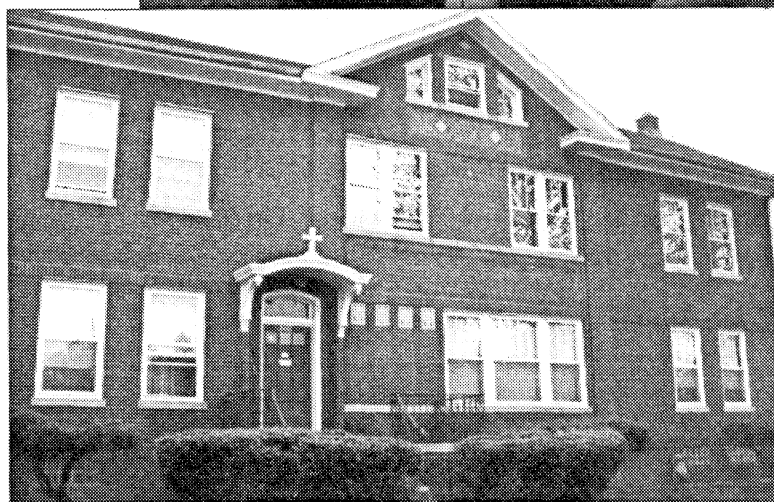
Budynek szkolny na Jakubowie
