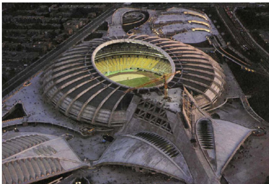
Fot. 71. Stadion i pływalnia olimpijska podczas igrzysk w Montrealu 1976 r.
