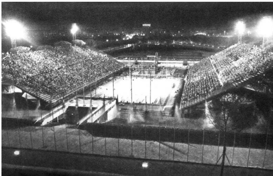
Fot. 55. Pływalnia olimpijska Rzym, 1960 r.
