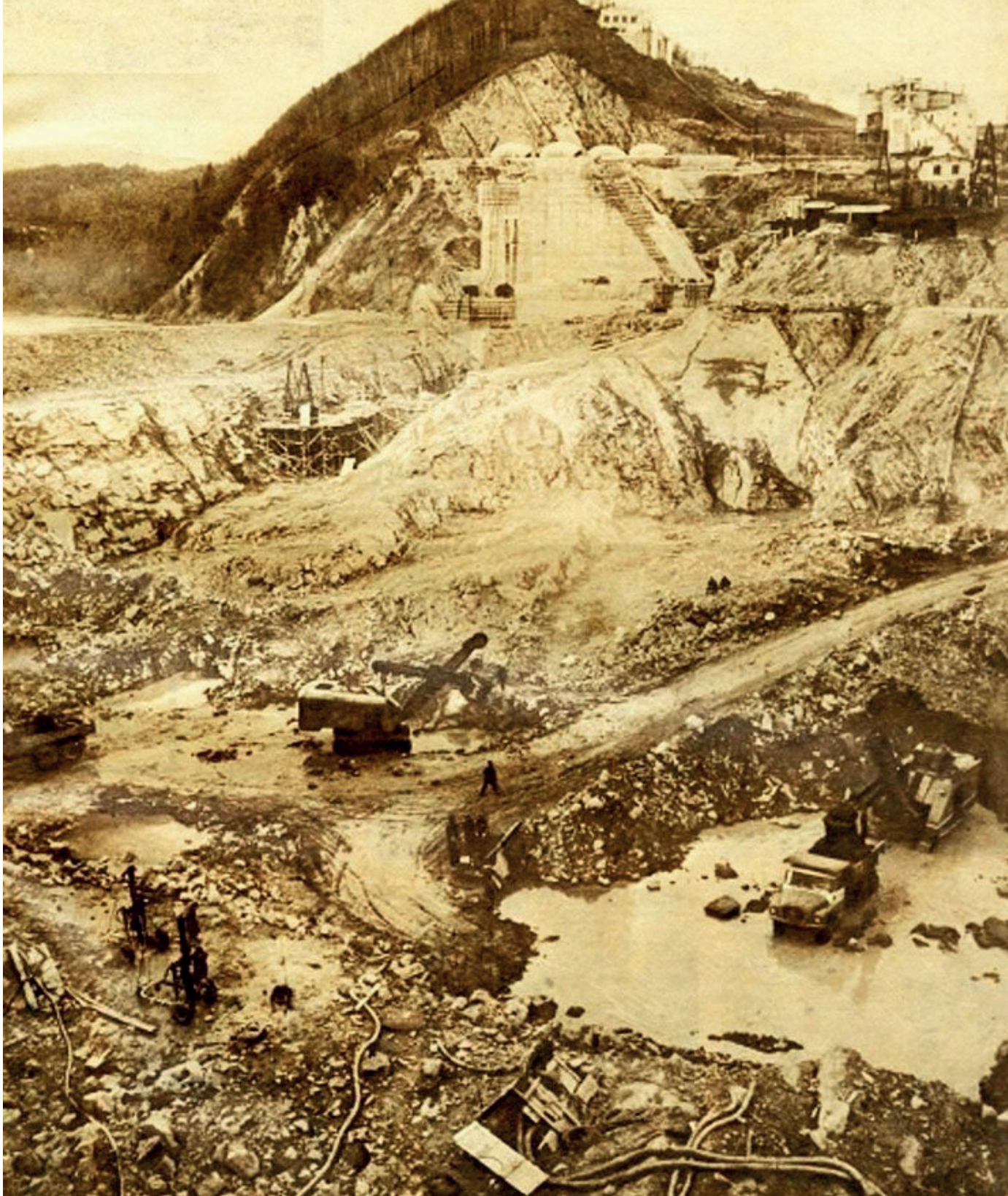
Budowa zapory, początek lat sześćdziesiątych XX wieku, zdjęcie archiwalne
