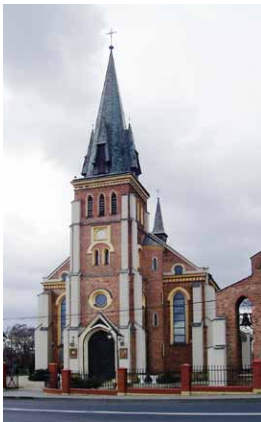
Il. 3. Kościół św. Bartłomieja w Nienadówce, 1895–1897. Widok od południowego wschodu. Fot. G. Ryba.
