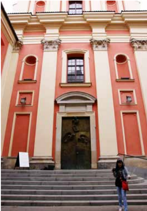
Il. 15. Kościół Matki Boskiej Łaskawej w Warszawie, XVII w., wejście w elewacji frontowej, widok od zachodu. Fot. G. Ryba.
