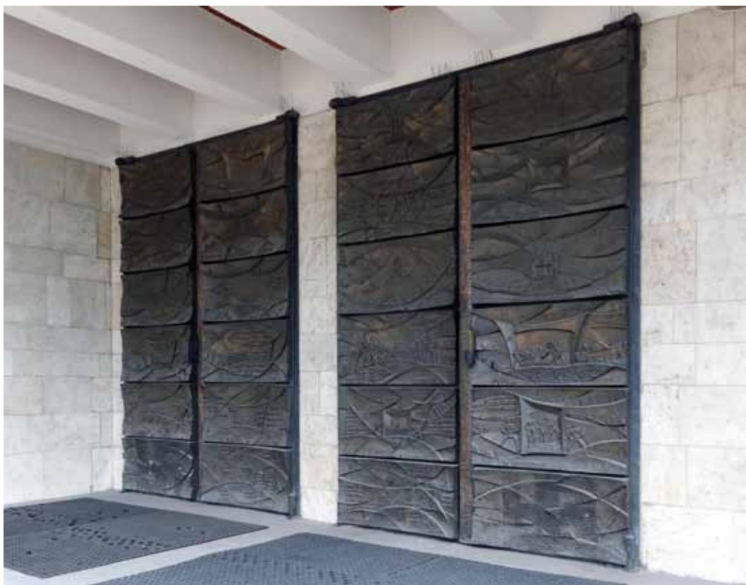
Il. 18. Kościół św. Maksymiliana w Tarnobrzegu, 1979–1982, arch. Józef Dutkiewicz, główne wejście. Fot. G. Ryba.
