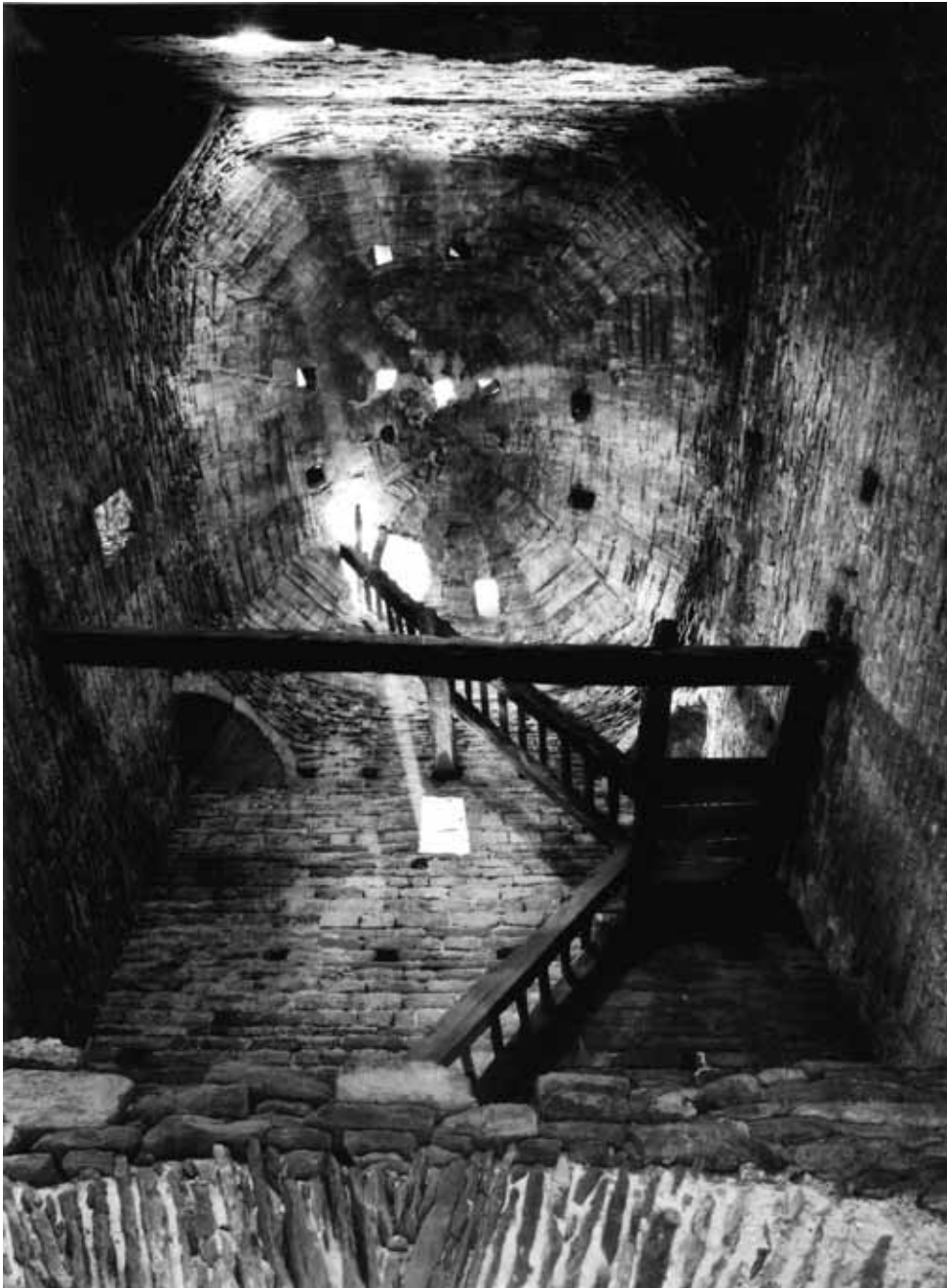
10. Wnętrze dzwonnicy kościoła w Cáceres, fot. za: J. Dieuzaide, Catalogne romane , t. 1
