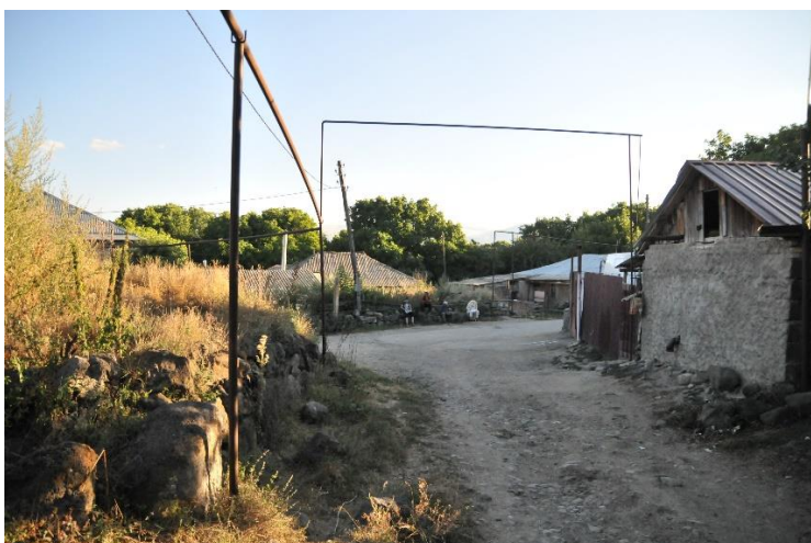
Fot. 35. System rur, dostarczających gaz do domów
