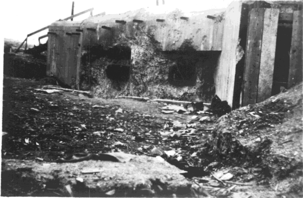
Zdjęcie 5. Zniszczony schron typu OPK mł. lejtn. I. Czaplina w Przemyślu
