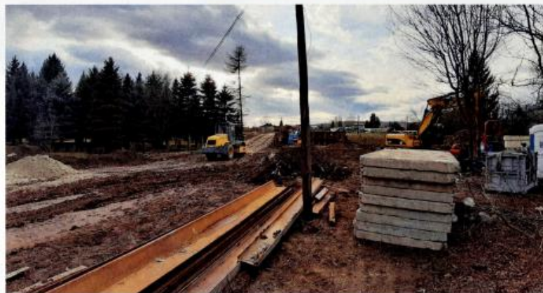
Abb. 4: Prace już trwają ("OJ"2/2020:3)
