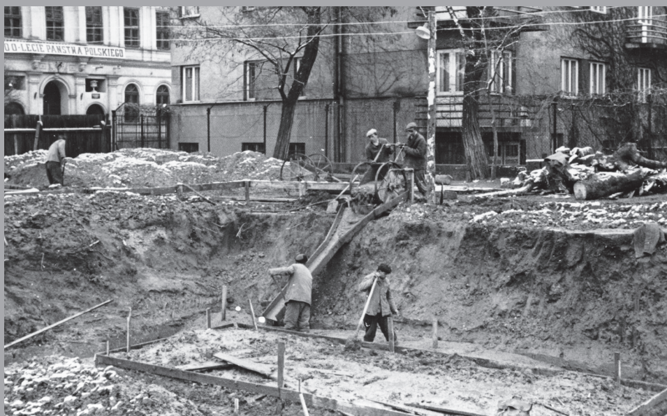
Fot. 35. Etap początkowy prac przy budowie budynku dla Szkoły Podstawowej nr 3 im. M. Konopnickiej w Tarnowie – Szkoły Pomnika Tysiąclecia Państwa Polskiego.
