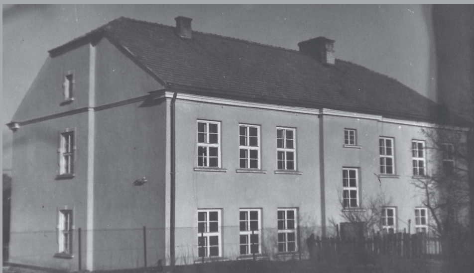
Fot. 45. Budynek Szkoły Podstawowej w Rygliszach po remoncie, rok szkolny 1971/1972.
