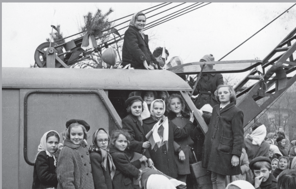
Fot. 34. Uczennice na placu budowy budynku dla Szkoły Podstawowej nr 3 im. M. Konopnickiej w Tarnowie, styczeń 1961 r.
