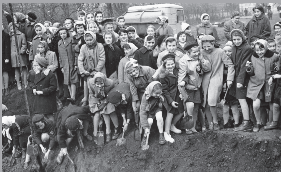
Fot. 33. Uczennice na placu budowy budynku dla Szkoły Podstawowej nr 3 im. M. Konopnickiej w Tarnowie, styczeń 1961 r.
