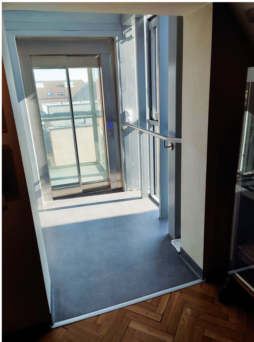
Fotografia 7. Winda zewnętrzna w zabytkowej kamienicy – Dom Mikołaja Kopernika w Toruniu
