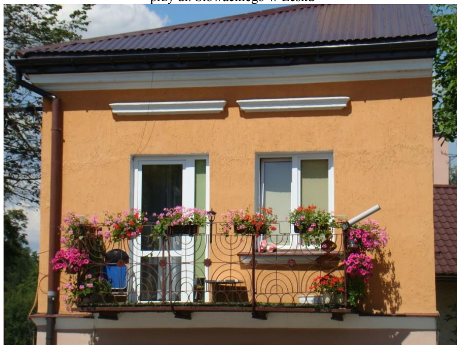
Fot. 33. Balkon wykonany z balustrady bimy znajdującej się niegdyś w leskiej synagodze. Kamienica przy ul. Słowackiego w Lesku
