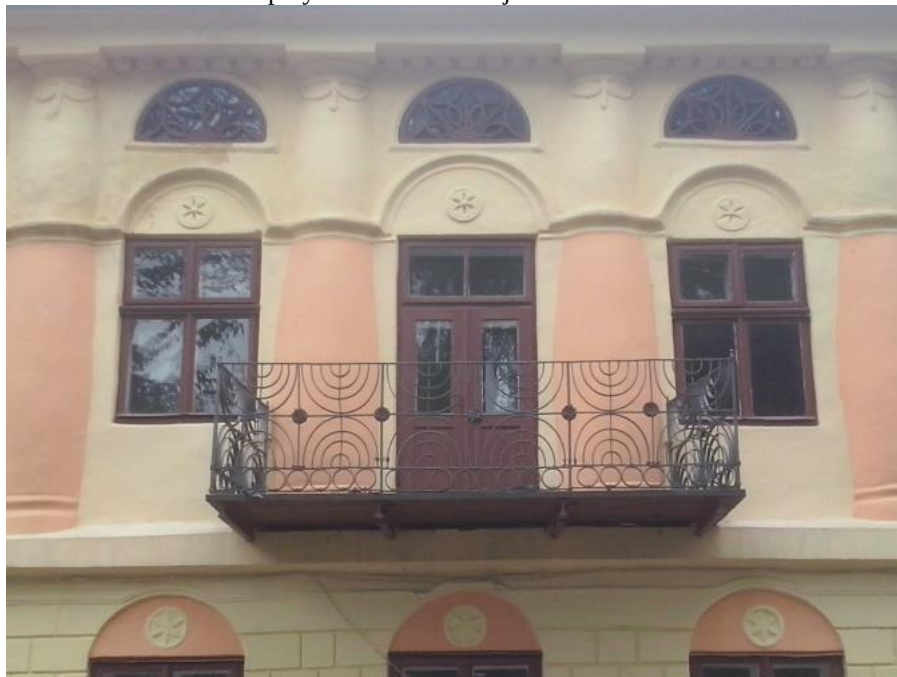
Fot. 32. Balkon wykonany z balustrady bimy znajdującej się niegdyś w leskiej synagodze. Kamienica przy ul. Unii Brzeskiej 11 w Lesku
