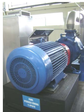
Rys. 2. Widok pompy wody czystej w ZUW w Rzeszowie [zdj. Karol Szalajko]
