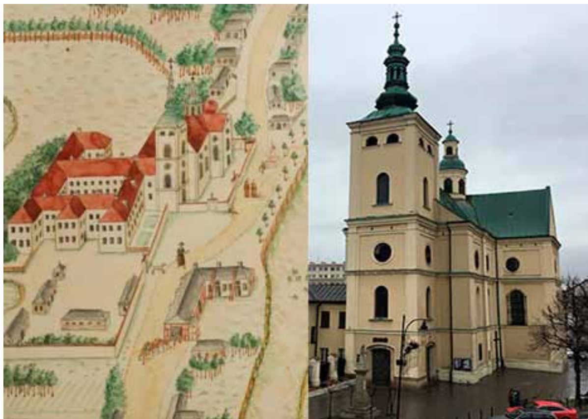
Ryc. 1. Bazylika oo. Bernardynów, 1762 (plan Wiedemanna – zbiory Muzeum Okręgowego w Rzeszowie) i obecny widok na kościół. Fot. M. Jabłkowski
