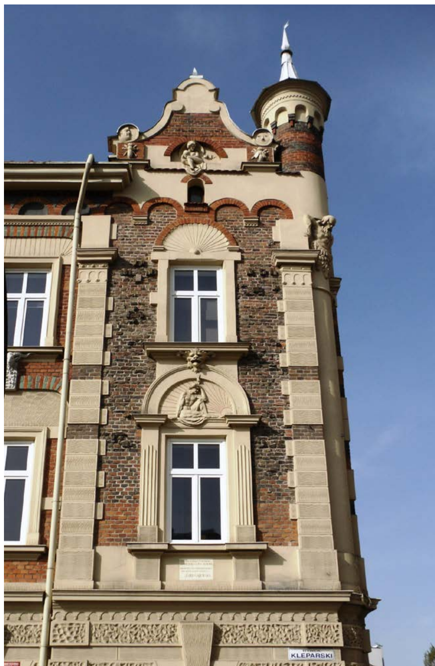
Fot. 4. Detale ryzalitu bocznego kamienicy
