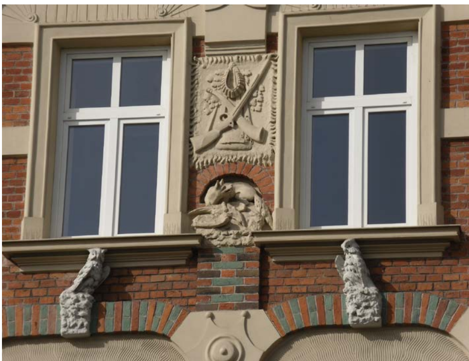
Fot. 3. Detale fasady południowej
