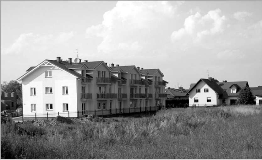
Fot. 29. Blok na osiedlu Biała. Przykład mieszania się zabudowy jednorodzinnej i wielorodzinnej
