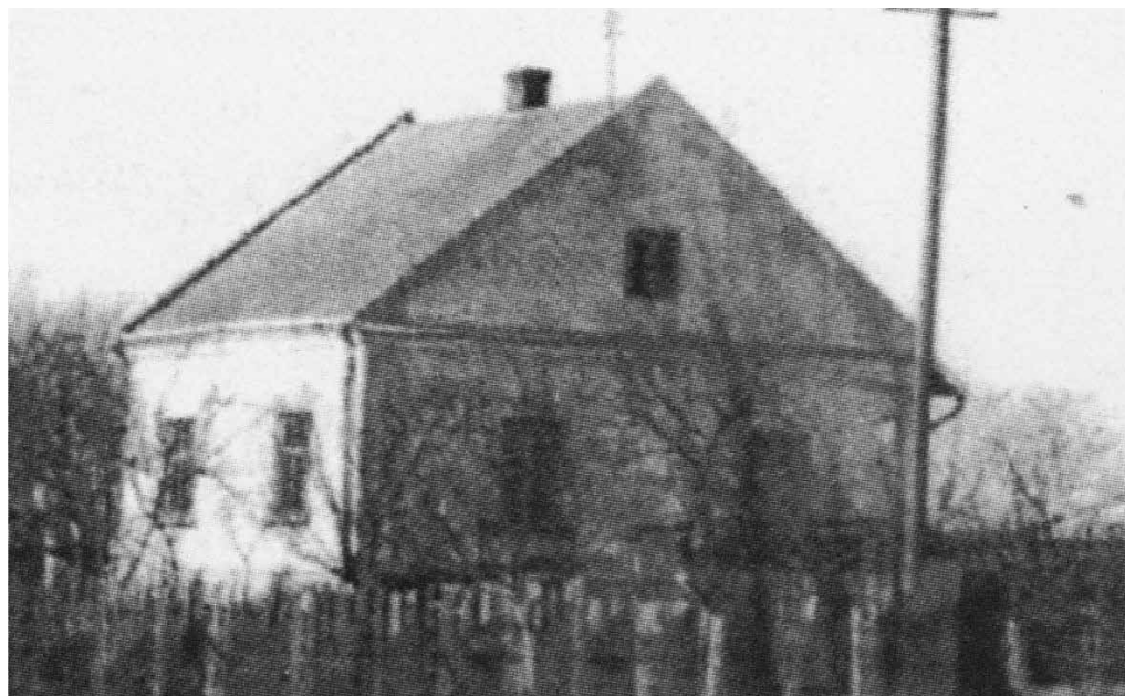
Rysunek 5. Budynek mieszkalny przy ul. Krakowskiej
