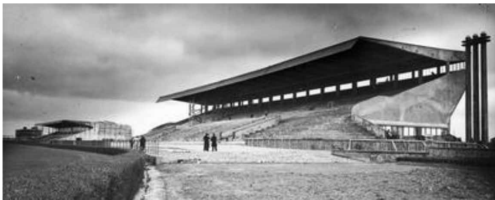
Rysunek 3. Zdjęcie z 1938 roku. Trybuny w trakcie budowy
