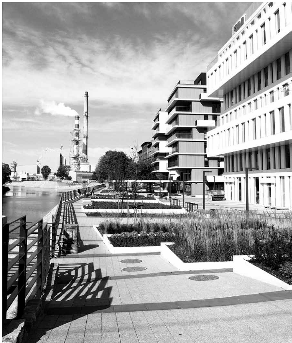
Rysunek 4. Nowa przestrzeń publiczna - deptak wzdłuż Odry powstały podczas realizacji budynku mieszkalnego Kurkowa 14 i biurowca Dubois 41.
